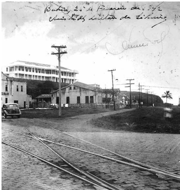
Figura 27 – Trilhos da pedreira de Amaralina (Rua Fonte do Boi)
