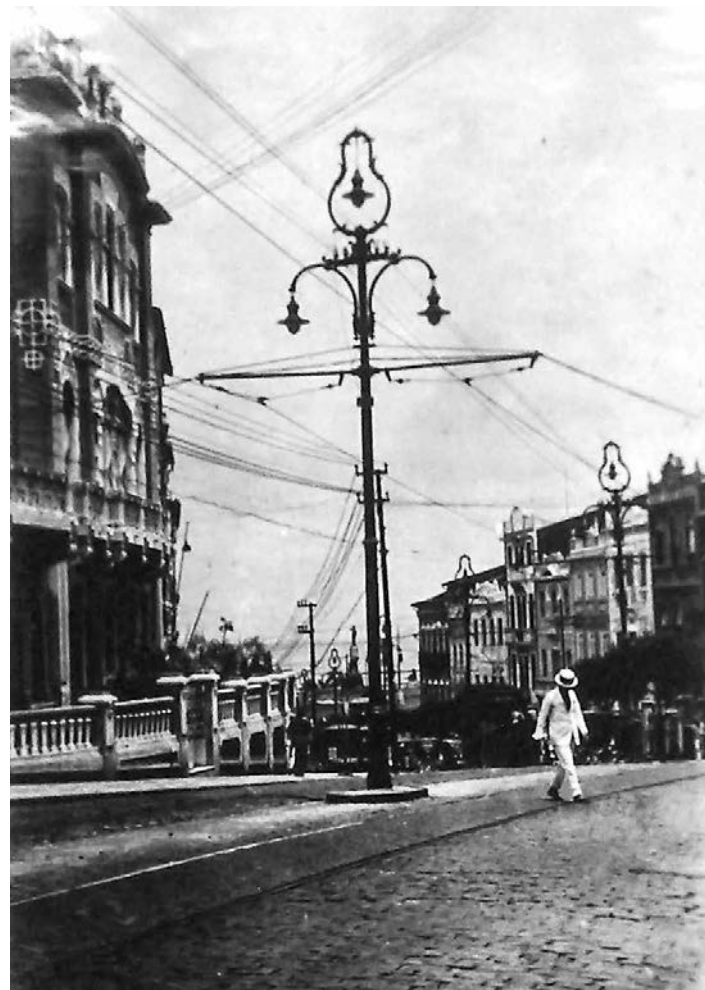
Figura 41 – Poste de ferro
