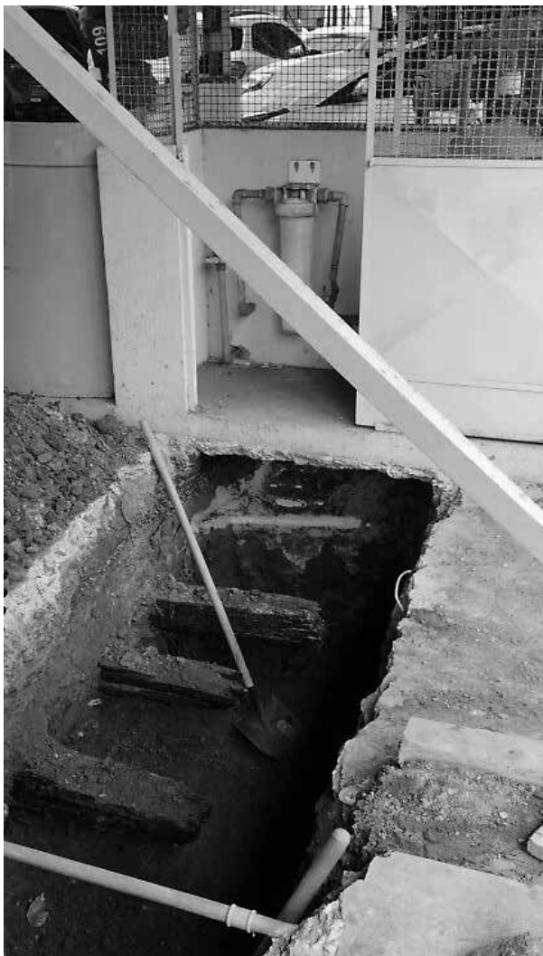
Figura 88 – Dormentes de madeira, pertencentes à linha de bondes Rio Vermelho de Cima, encontrados na atual Avenida Garibaldi
