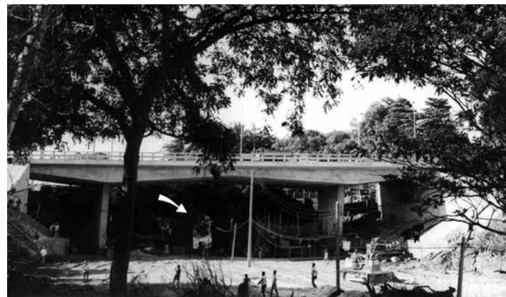
10a) Durante a construção do Viaduto General Mascarenhas de Moraes
