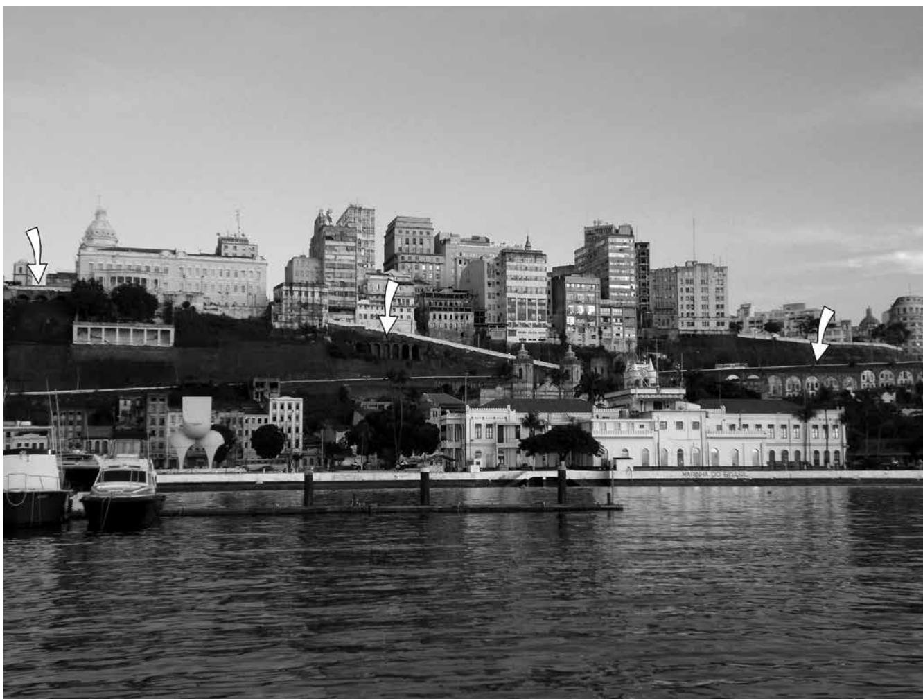
Figura 5 – Perfil de Salvador, com indicação de arcadas diversas ao longo da encosta: estruturas de sustentação da Praça Municipal, de uma edificação e da Ladeira da Montanha
