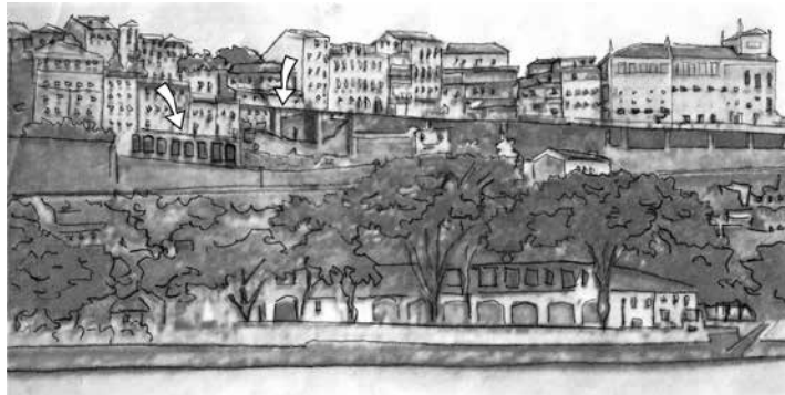
Figura 42 – Viaduto Bandeira de Mello, visto no perfil da cidade (seta à direita); arcos que serviam de base à edificação (seta à esquerda)
