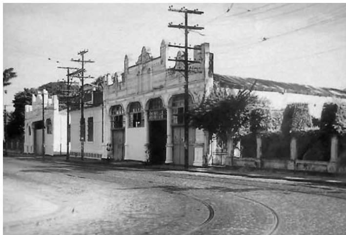
Figura 80 – Subestação e Barracão (oficina) da Graça
