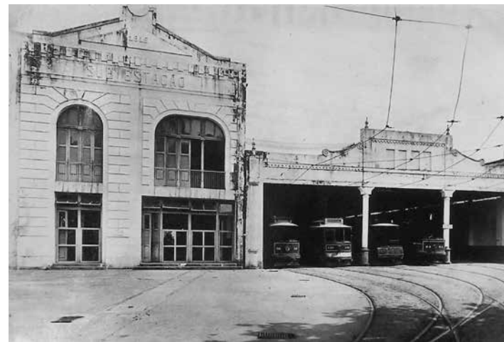
Figura 82 – Subestação e Barracão (oficina) de Santana (esquina com a Rua J. J. Seabra)
