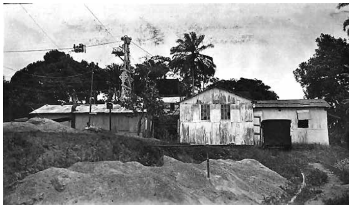
Figura 84 – Usina do Retiro
