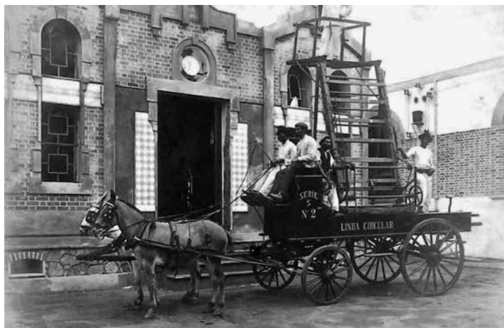
Figura 15 – Carro-socorro, que não necessita de trilhos – Tração animal
