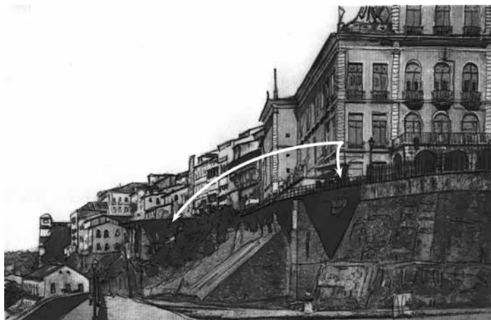
Figura 43 – Viaduto Bandeira de Mello. Ver gradil, indicado por setas
