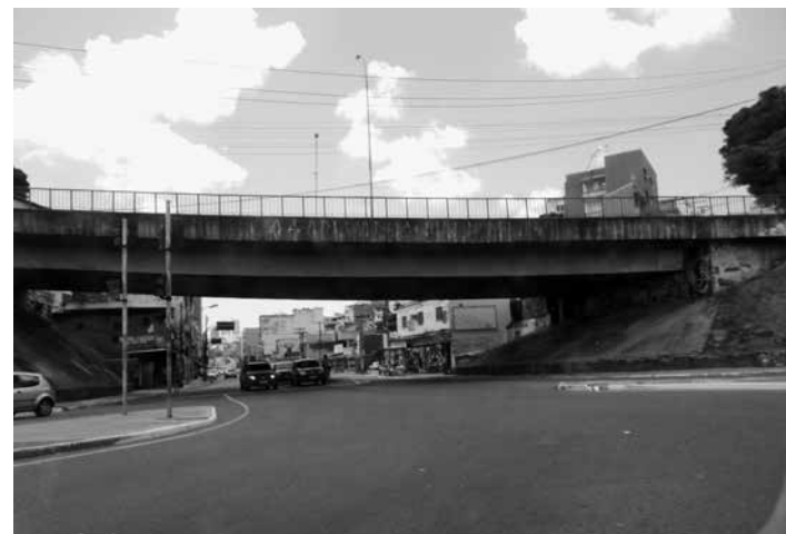
Figura 12 – Viaduto da Ladeira do Arco
