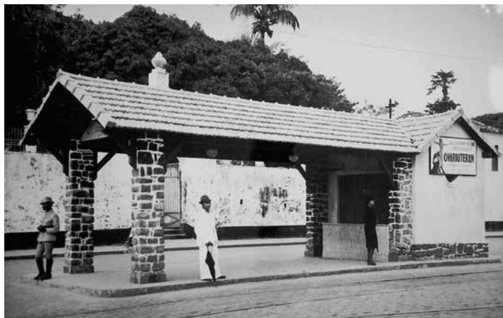
Figura 72 – Abrigo do Campo Santo
