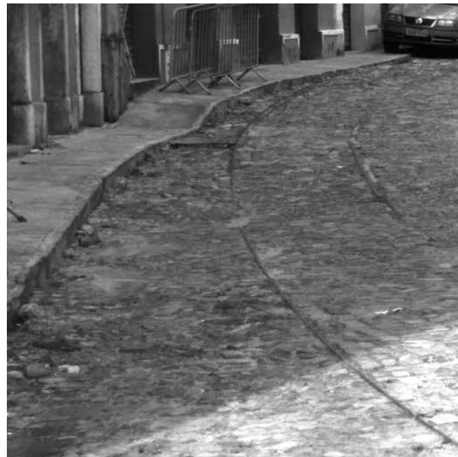
Figura 33 – Trilhos próximos à Igreja da Conceição da Praia
