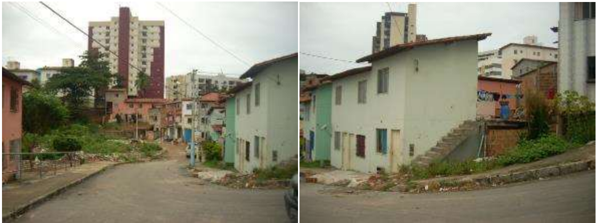
Figura 22: Ausência de tratamento das áreas livres
