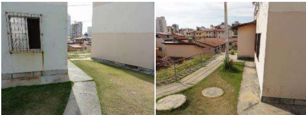
Figura 23: Acesso à escada 02, construída no final da 1ª etapa de obras
