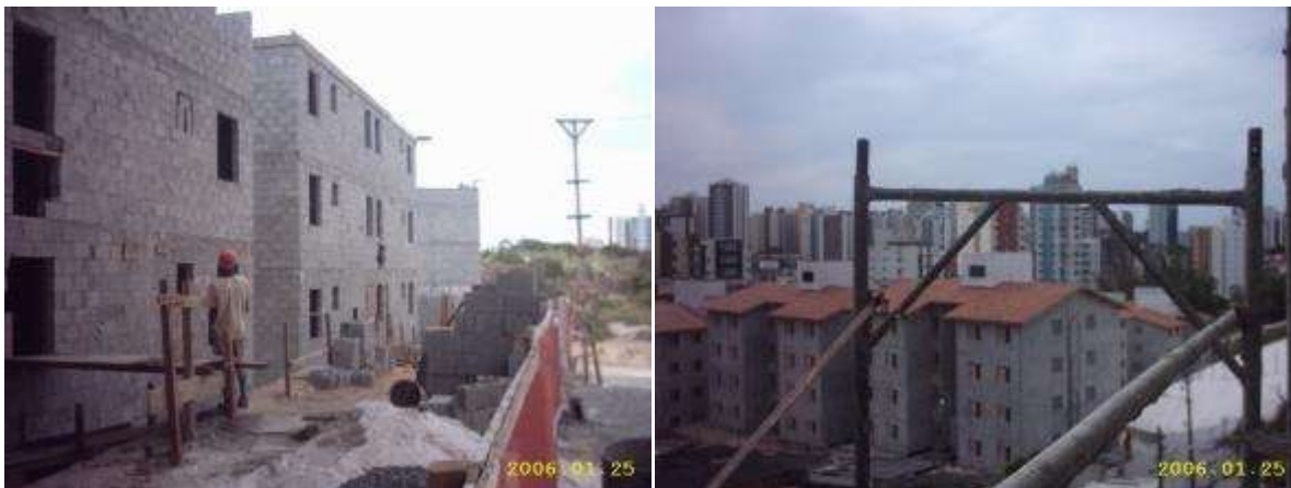
Figura 13: Imagens da construção das unidades habitacionais
