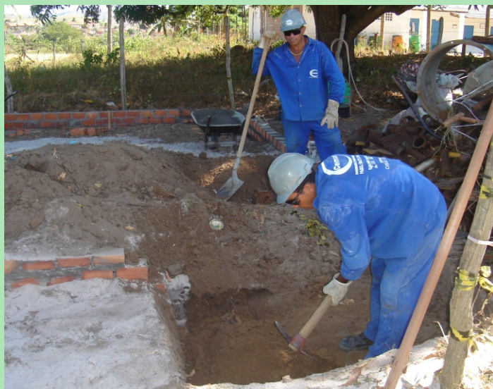
Construção de baia para armazenamento de sucata
