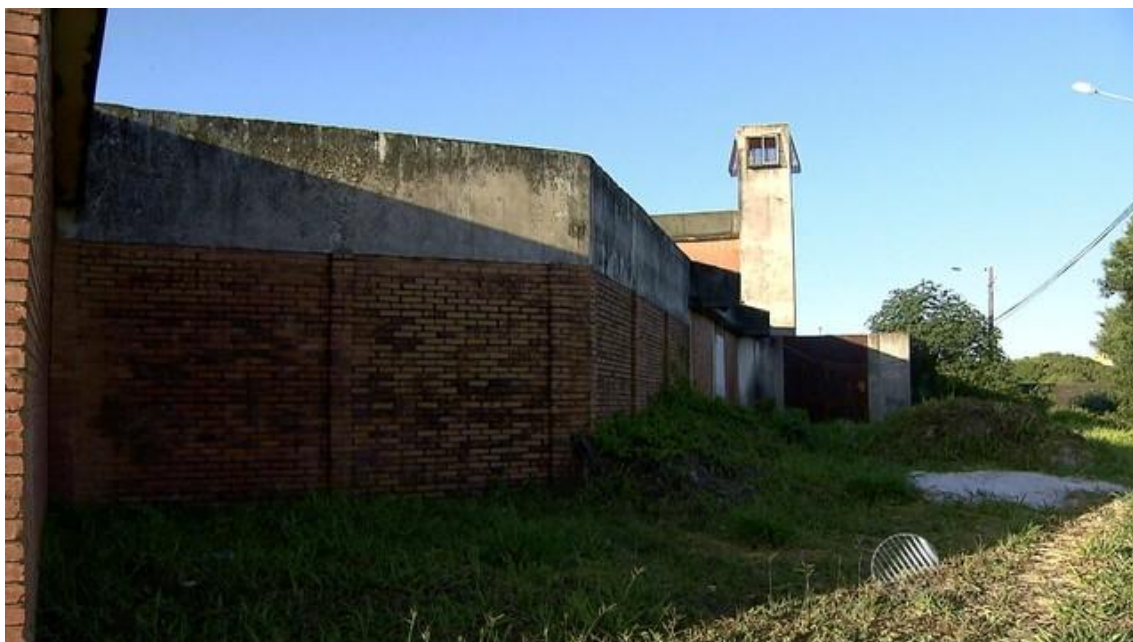
Figura 4 - Torre de Observação
