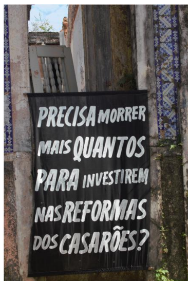
Figura 07 – Cartaz colocado na fachada de uma casa demolida, 2017
