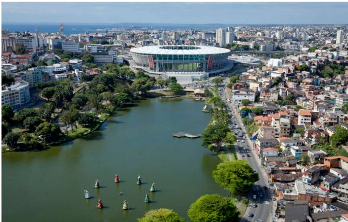
Ilustración 1 - Vista panorámica de la Arena Fonte Nova después de la reconstrucción
