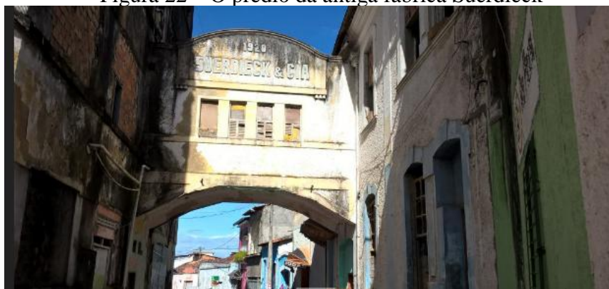
Figura 22 – O prédio da antiga fábrica Suerdieck
