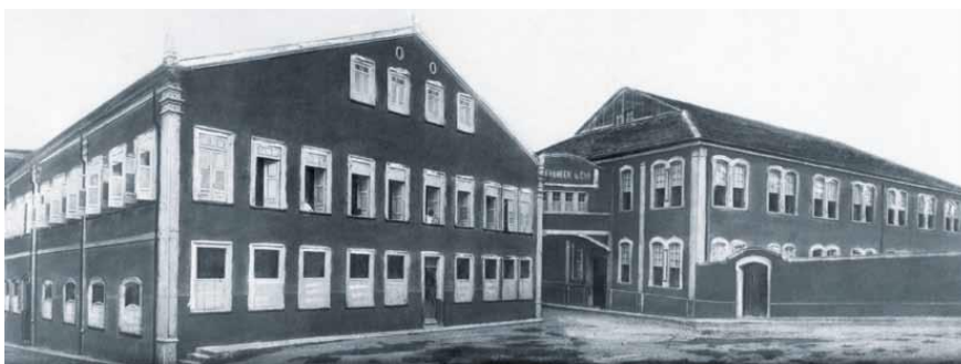
Figura 21 – Os dois blocos da Fábrica Suerdieck em funcionamento
