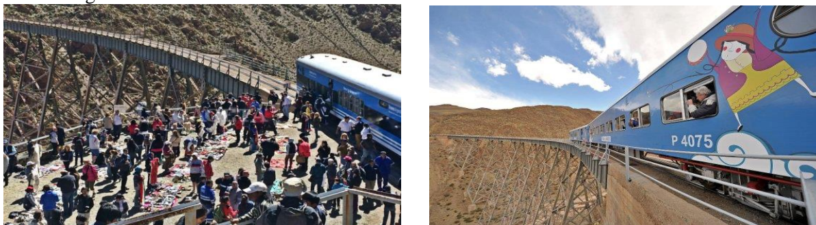
Figura 28 - Foto Parada del Tren Viaducto La Polvorilla
