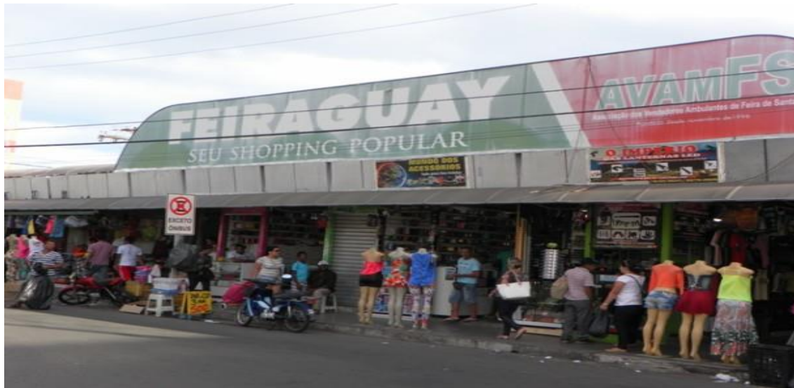
Figura 4: Fachada do Feiraguay
