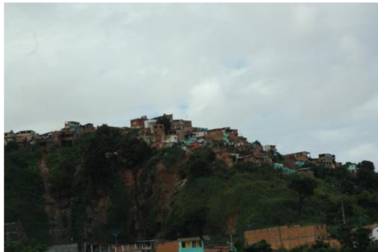
Figura 28: Ocupações em áreas de risco no bairro do Lobato, 2009.
