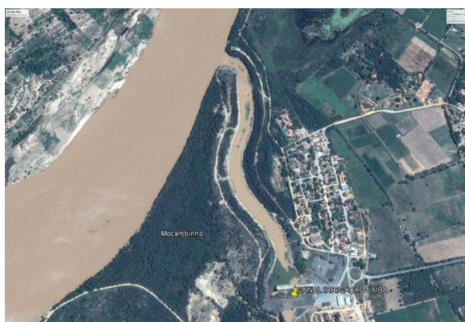
Figura 23- Canal de irrigação do Projeto Jaíba, na cidade de Jaíba, Minas Gerais.
