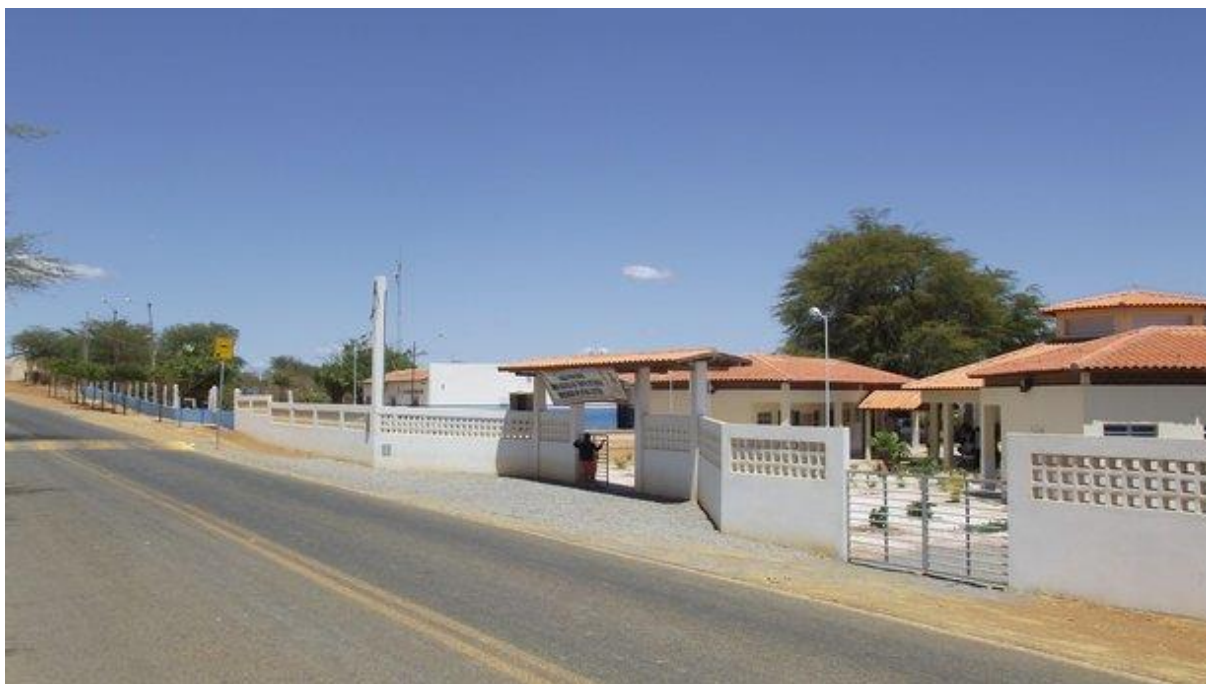
Figura 04 - Fachada da escola onde, à esquerda, com detalhes em azul, está o prédio antigo e, à direita, o prédio mais novo incorporado à escola.
