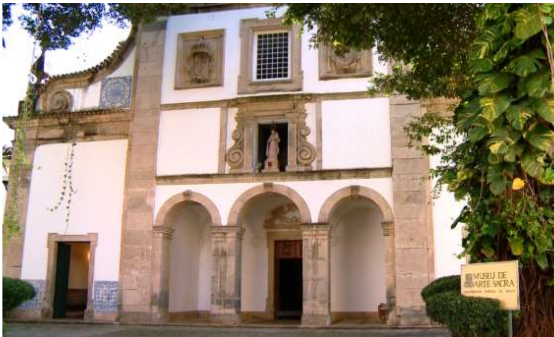
Figura 2 - Fachada da Igreja do antigo convento carmelitano de Santa Tereza Ávila (atual, MAS/UFBA)
