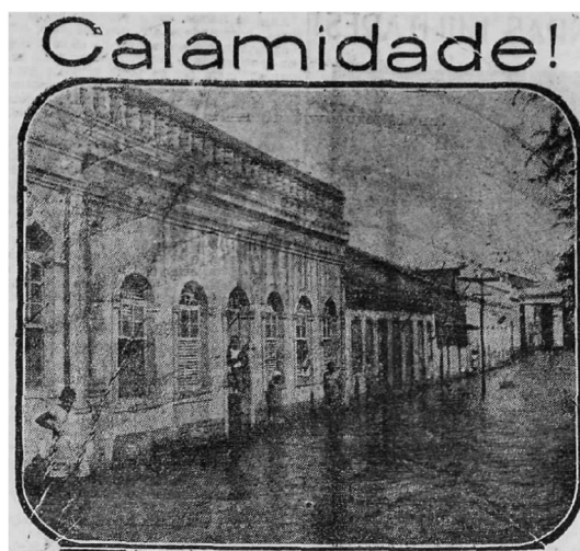
FIGURA 20: RUA DR. JUVENCIO LIMA, CENTRO DE JUAZEIRO, TOMADA PELAS ÁGUAS DO RIO SÃO FRANCISCO
