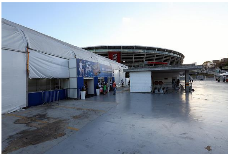
Figura 16 - Áreas Externas (Edifício Garagem - EDG)
