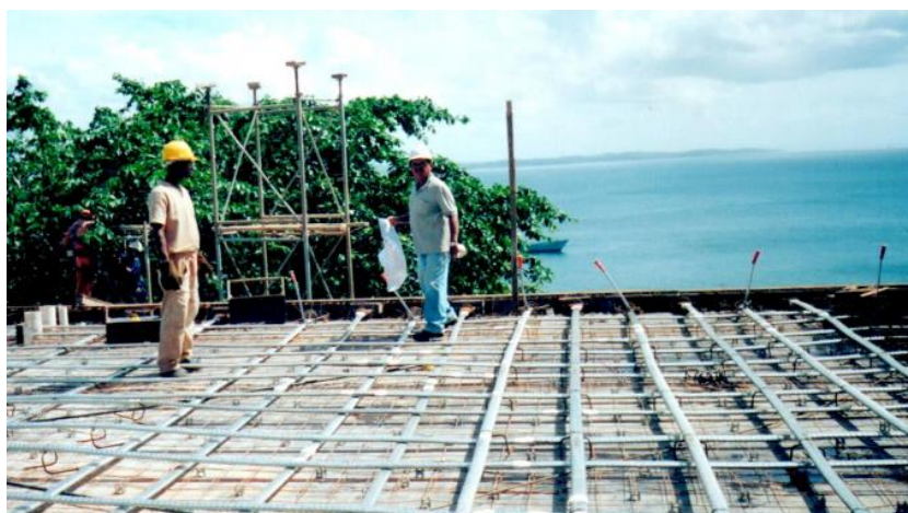
Figura 14: Montagem de laje com pós-tração aderente
