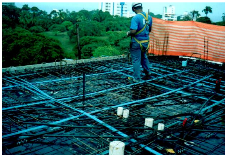
Figura 17: Montagem de laje com pós-tração não aderente
