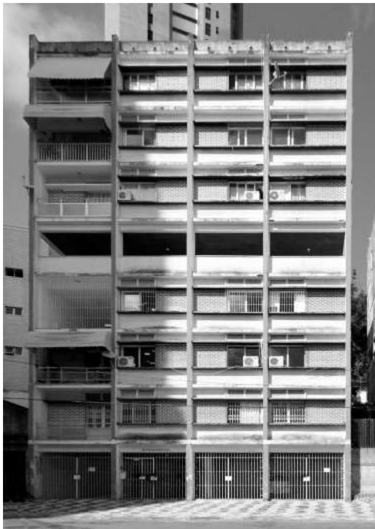
Edifício Rosa Regina, fachada à rua Plínio Moscoso Foto Márcio Correia Campos
