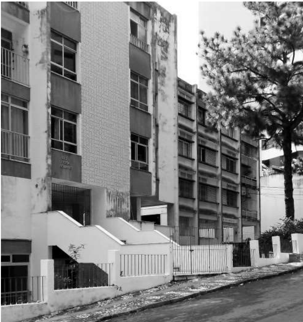
Acesso aos edifícios Rosa Rejane e Rosa Regina pela rua Dr. Christiano Ottoni Foto Márcio Correia Campos
