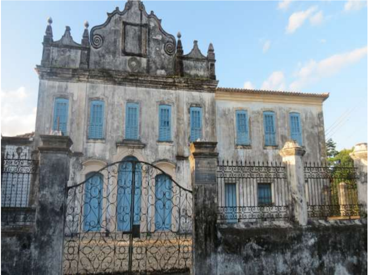
Fig. 2: Imagem atual da fachada do Recolhimento dos Humildes
