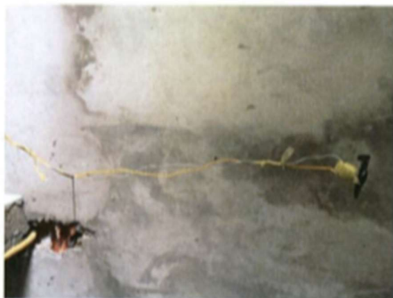
Gambiarra com fios elétricos expostos
