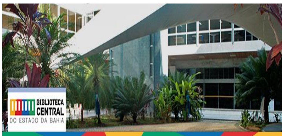
Figura N°8. Fachada Biblioteca Central do Estado da Bahia. Fonte 55 .
