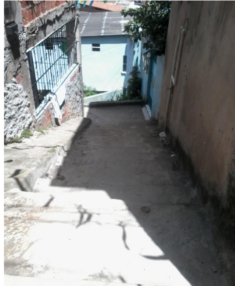
Fig.24: Vista à cavaleiro da escadaria
