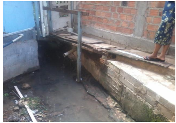
Fig.31: Esgoto a céu aberto em frente as casas
