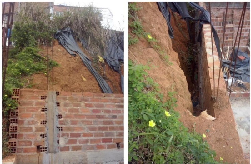
Figura 197 - Imagens atual do talude
