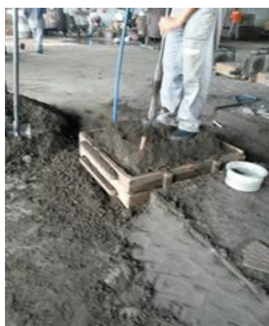
Figura 19c – Compactação com socador pneumático
