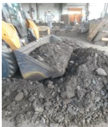
Figura 25c – Limpeza da área após desmoldagem
