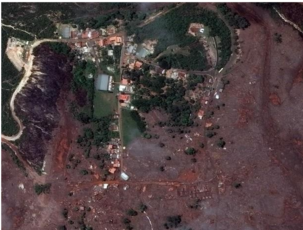
Figura 21 - Distrito de Bento Rodrigues depois da ruptura da barragem.
