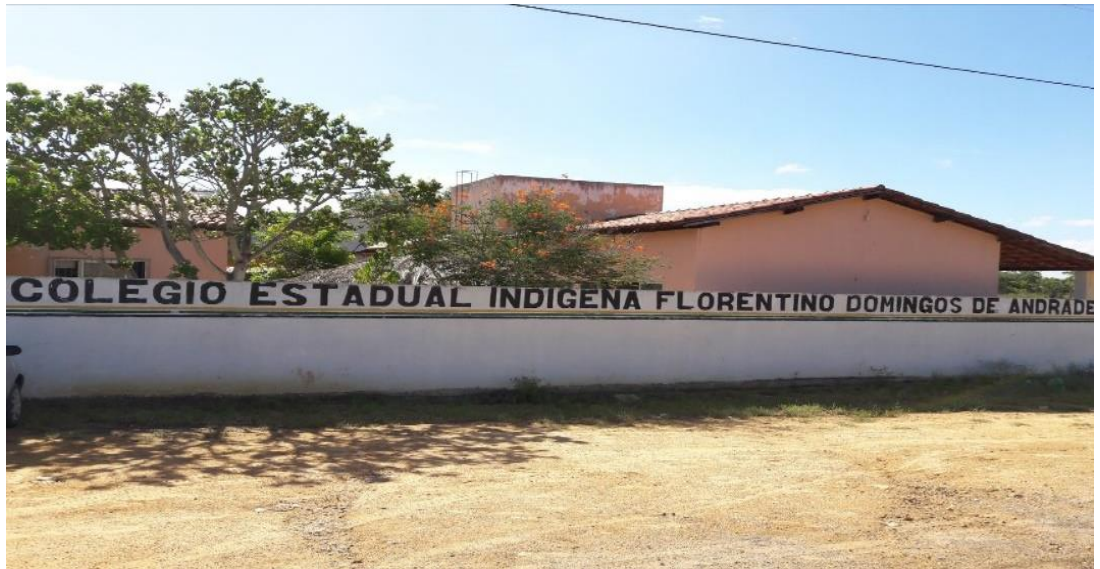
Figura 4 – Fachada da Escola Florentino
