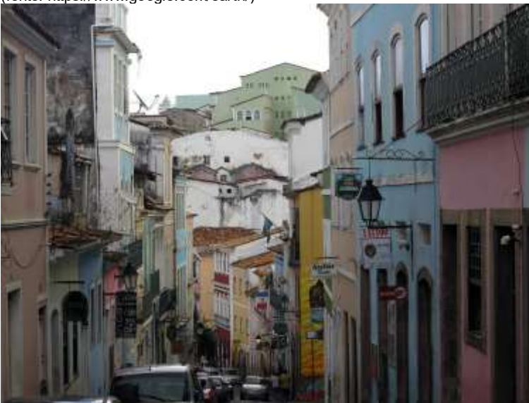
Figura 85 | Vista do conjunto urbano do Largo do Pelourinho, a partir da Ladeira do Carmo, apresentando um conjunto de empenas laterais, entre as quais se destaca uma empena "mutilada" no edifício onde está instalado o Hotel Pelourinho. A introdução de um pátio no limite lateral do edifício produz uma ruptura na configuração da empena. (foto do autor, nov./2016)
