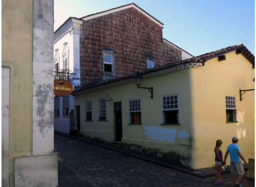
Figura 4 | Edifício na Rua Francisco Muniz Barreto (antiga Rua das Laranjeiras), Salvador. Empena vazada e revestida com telha cerâmica capa-canal 15 . (foto do autor, out./2016)
