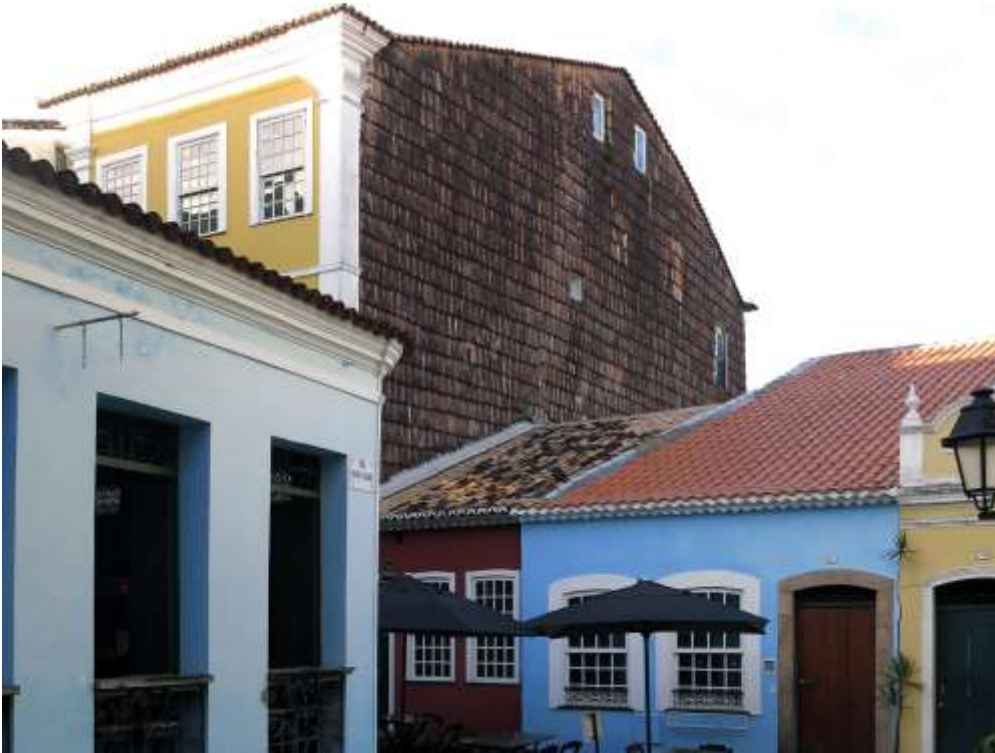
Figura 156 | Vista da Rua das Laranjeiras a partir da Rua Santa Isabel, com o campo visual dominado por uma empena que manifesta os quatro critérios consolidados. A empena de oitão é texturizada e vazada, salientando-se a presença do algeroz no encosto do edifício adjacente (foto do autor, out./2016)
