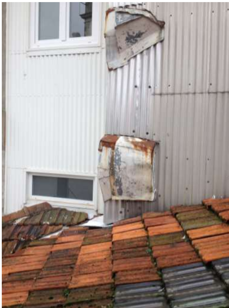
Figura 163 | Vista de um sobrado na Rua de Cimo de Vila, no centro histórico do Porto, com revestimentos metálicos na empena lateral e nas pedras de espera. (foto do autor, dez./2016)
