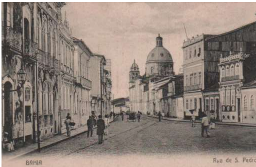
Figura 20 | Cartão postal de 1900 da Rua de São Pedro, atualmente inexistente devido à introdução da Avenida Sete de Setembro. Vista em direção ao Convento de São Bento. Pelo formato e textura da empena sul do sobrado com três pavimentos do lado direito da rua, acredita-se que o revestimento fosse em chapa zincada ondulada. (fonte: FIFB. Cota CP-15.660)
