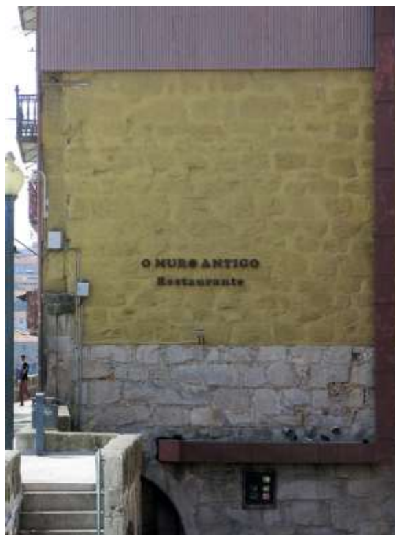
Figura 178 | Vista da empena lateral da Rua de Cimo do Muro, na atualidade. De acordo com o critério de tratamento de superfície, trata-se de uma empena texturizada, vazada e figurativa com mensagem publicitária. (foto do autor, ago./2017)
