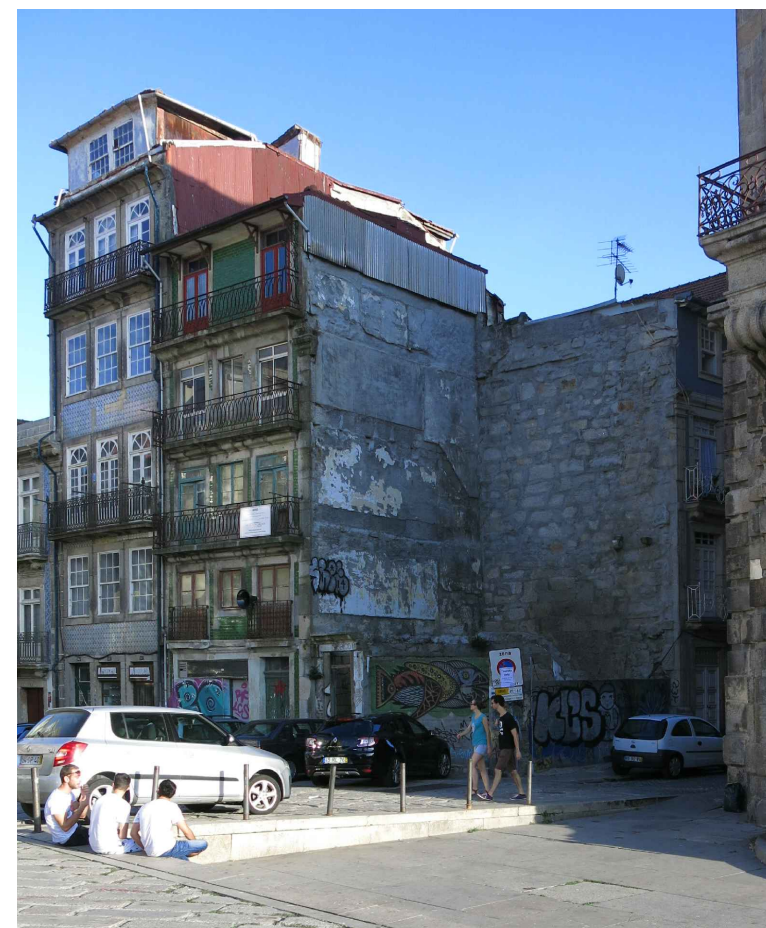
FOTO C | Vista a partir do Largo Amor de Perdição, em direção à Rua São Bento da Vitória. Devido à deterioração do edifício da esquina da quadra, as duas empenas laterais dos edifícios adjacentes adquiriram visibilidade e, em função da sua dimensão e relação com a paisagem urbana, apresentam um protagonismo significativo. De acordo com as categorias propostas no presente trabalho, considera-se que se tratam de duas empenas fragilizadas. (foto do autor, ago. 2017).
