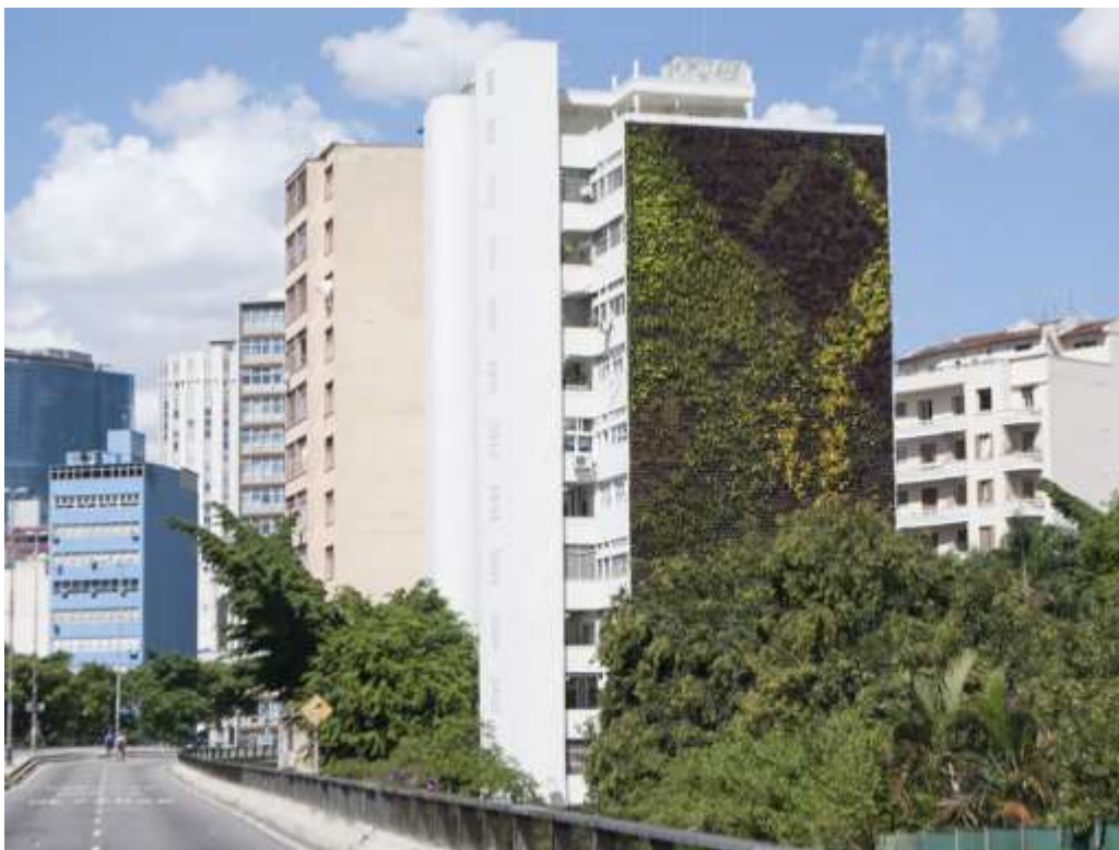
Figura 1 | Vista a partir do Minhocão com empena lateral de edifício na Rua Sebastião Pereira, revestida com jardim vertical. Fotografia de Felipe Gabriel e M.90° [201-] (fonte Movimento 90°. Disponível em: < http://movimento90.com/parquesverticais/ >. Acesso em 21 jun. 2017)
