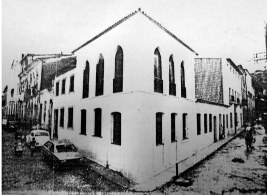
Figura 24 | Fotografia com um conjunto de ruínas recuperadas entre a Rua J. Castro Rabelo e a Rua João de Deus. Empena sudeste refeita com revestimento em telha cerâmica capa-canal. (fonte: IPAC, 1984).
