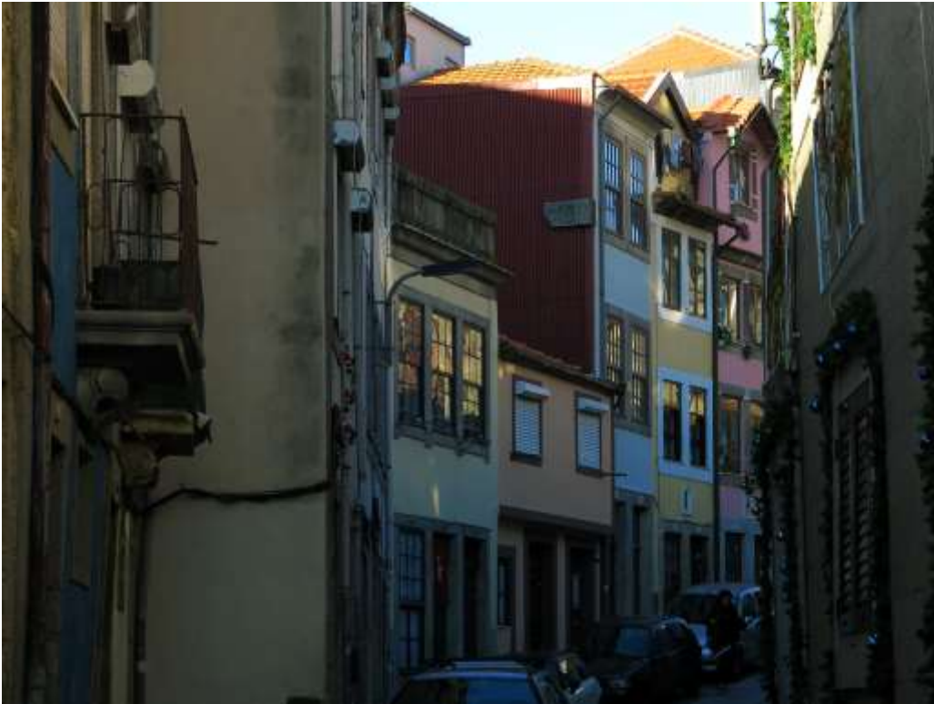
Figura 153 | Vista da Rua da Vitória, no Morro da Vitória, de um edifício com empena lateral revestida em chapa zincada ondulada e com a presença de uma pedra de espera. (foto do autor, dez./2016)
