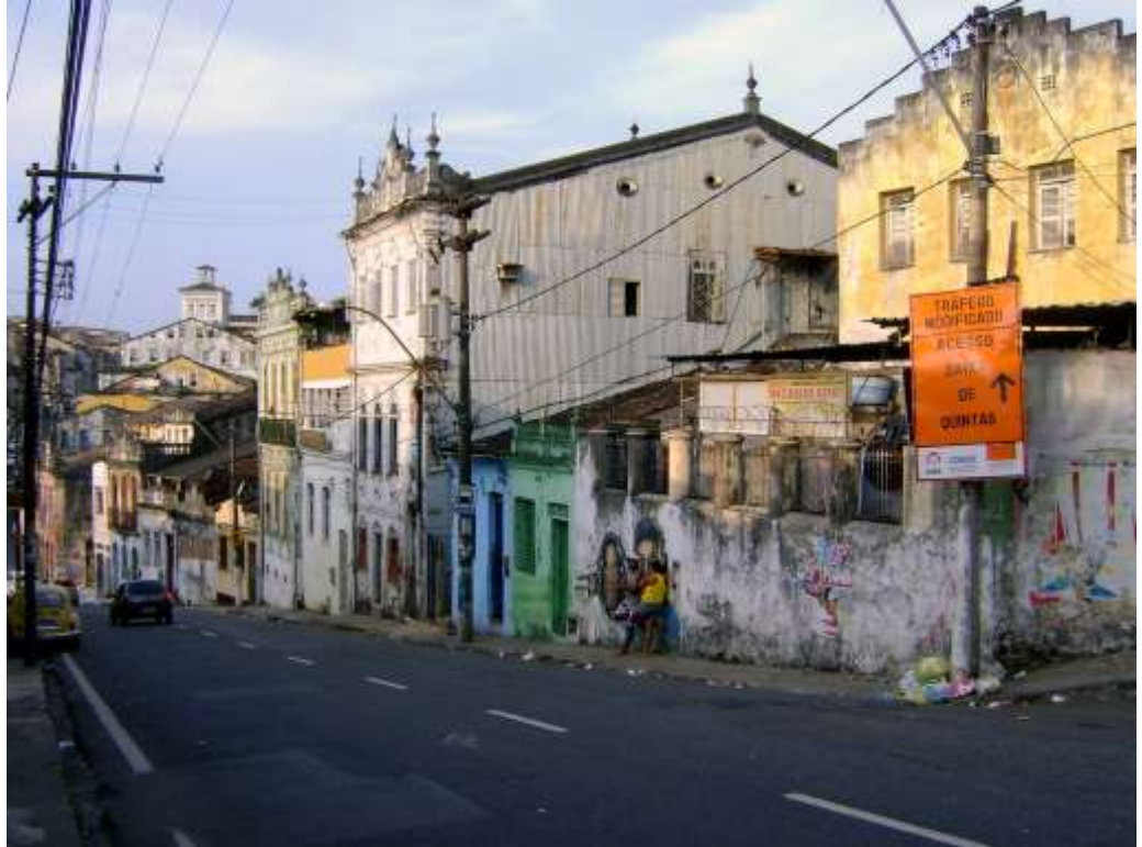
Figura 21 | Rua S. José de Cima no Bairro do Barbalho. É possível constatar na empena sul do sobrado de três pavimentos do lado direito da rua o revestimento em chapa zincada ondulada. Salienta-se a variedade das formas dos vãos presentes na empena lateral. Pelo ritmo e tratamento dos vãos circulares do desvão da cobertura, acredita-se que estes possam fazer parte do projeto original. Já o restante dos vãos, revelando certa aleatoriedade compositiva e formatos diversos, denunciam uma eventual execução posterior. (foto realizada por Luiz Antonio Fernandes Cardoso, out./2010)
