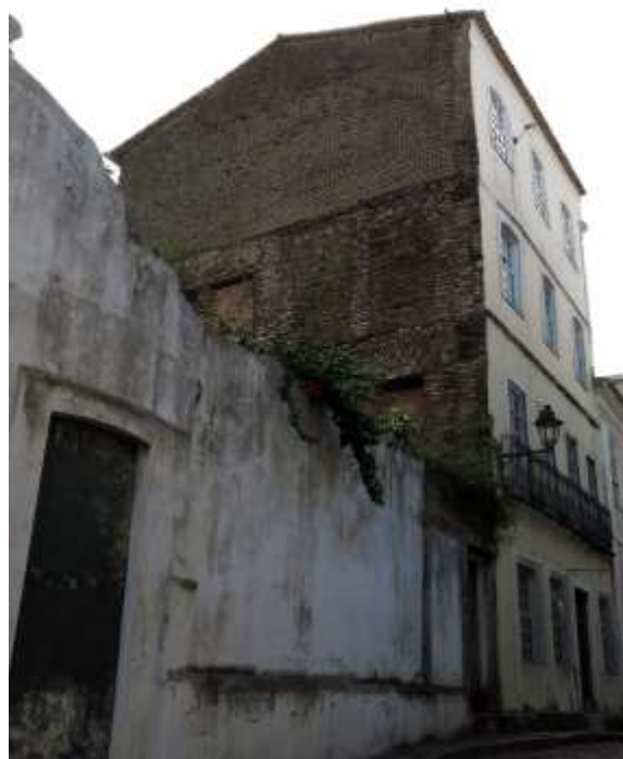
Figura 164 | Vista de sobrado na Rua Leovigildo de Carvalho, em Salvador. O sobrado revela uma empena lateral cujo tratamento de superfície se apresenta sem qualquer tipo de acabamento, possivelmente pela eventual derrocada da edificação adjacente. (foto do autor, out./2016)
