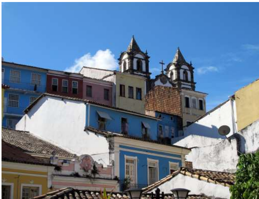
Figura 26 | Vista do conjunto edificado da Ladeira do Carmo e da Rua do Passo. Observa-se prevalentemente empenas orientadas a sul revestidas com argamassas pintadas e um exemplar revestida em telha cerâmica capa-canal. As empenas laterais pintadas são majoritariamente à cor branca. (foto do autor, mar./2015)
