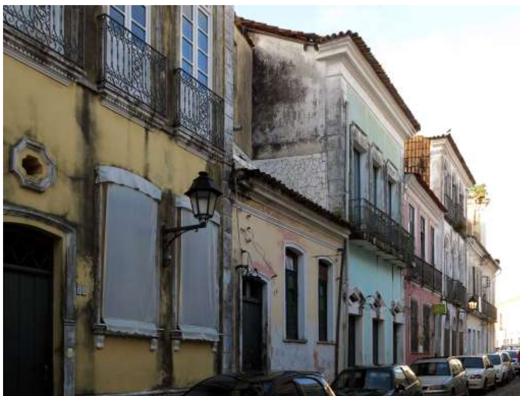
Figura 162 | Vista parcial do conjunto urbano da Rua do Passo, no centro histórico do Salvador. A empena lateral em primeiro plano revela-se como uma empena com tratamento de superfície misto, com revestimento superior liso em argamassa e revestimento inferior texturizado em cerâmica. Embora o revestimento em cerâmica não assuma protagonismo em relação ao espaço urbano, considera-se inadequada a utilização deste material como revestimento de superfícies no contexto do centro histórico de Salvador (foto do autor, out./2016).
