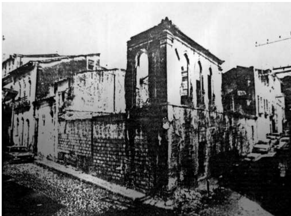
Figura 23 | Fotografia com um conjunto de ruínas entre a Rua J. Castro Rabelo e a Rua João de Deus (fonte: IPAC, 1984).
