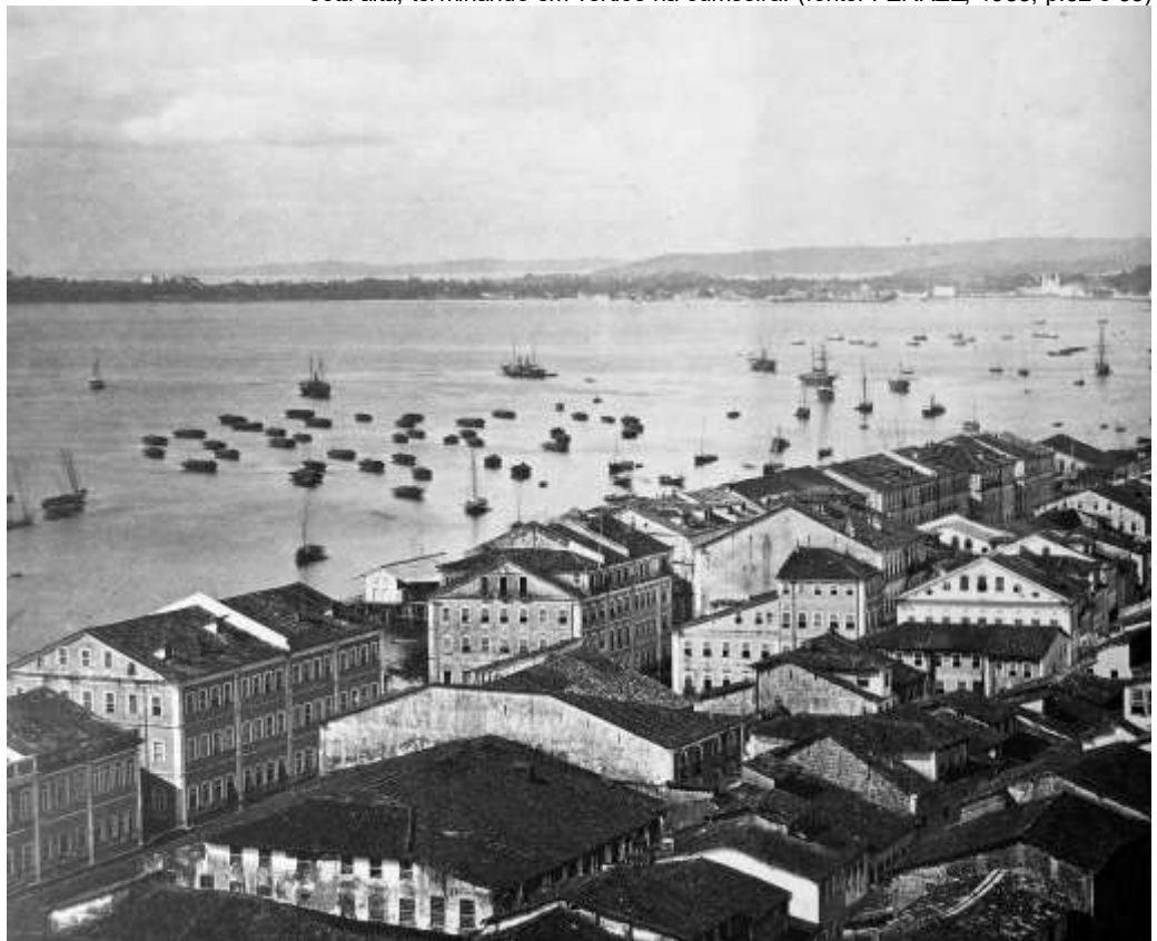
Figura 16 | Fragmento da fotografia de Benjamin Mulock de 1860, com vista da cidade baixa, onde se constata a prevalência das formas triangulares das empenas laterais dos edifícios. É possível observar uma inusitada empena lateral esconsa e, entre os materiais de revestimento das empenas, registra-se a prevalência das argamassas e um exemplar revestido em telha cerâmica capa-canal. (fonte: FERREZ, 1988, p.34 e 35)
