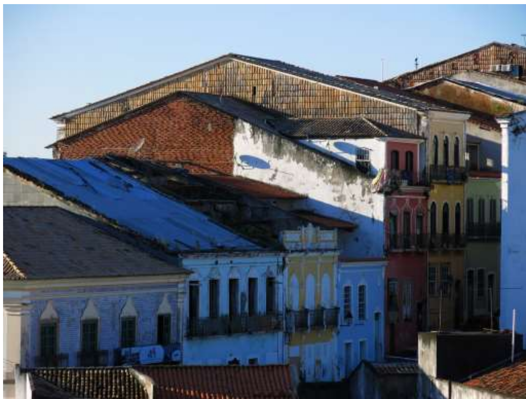
Figura 142 | Vista do casario da Rua do Passo registrada a partir do edifício do Hotel do Pelourinho. De modo mais destacado pode-se observar empenas texturizadas com revestimento em telha cerâmica capa-canal e uma empena revestida parcialmente com argamassa pintada de branco e o restante da parede de suporte sem qualquer revestimento. Nas empenas revestidas com telha cerâmica, as telhas apresentam a parte convexa orientada para o exterior (foto do autor, mai./2017)
