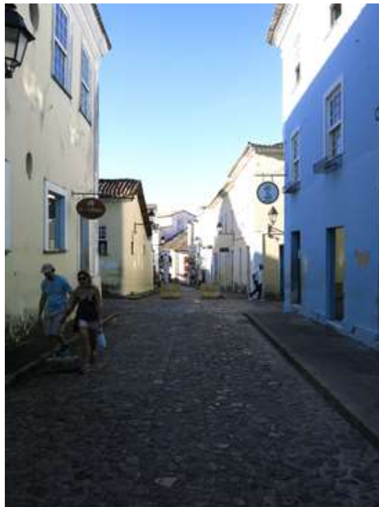
Figura 63 | Estação A da Rua Gregório de Matos (antiga Rua Maciel de Baixo) em direção ao Largo do Pelourinho e do Carmo. (foto do autor, abr./2017)
