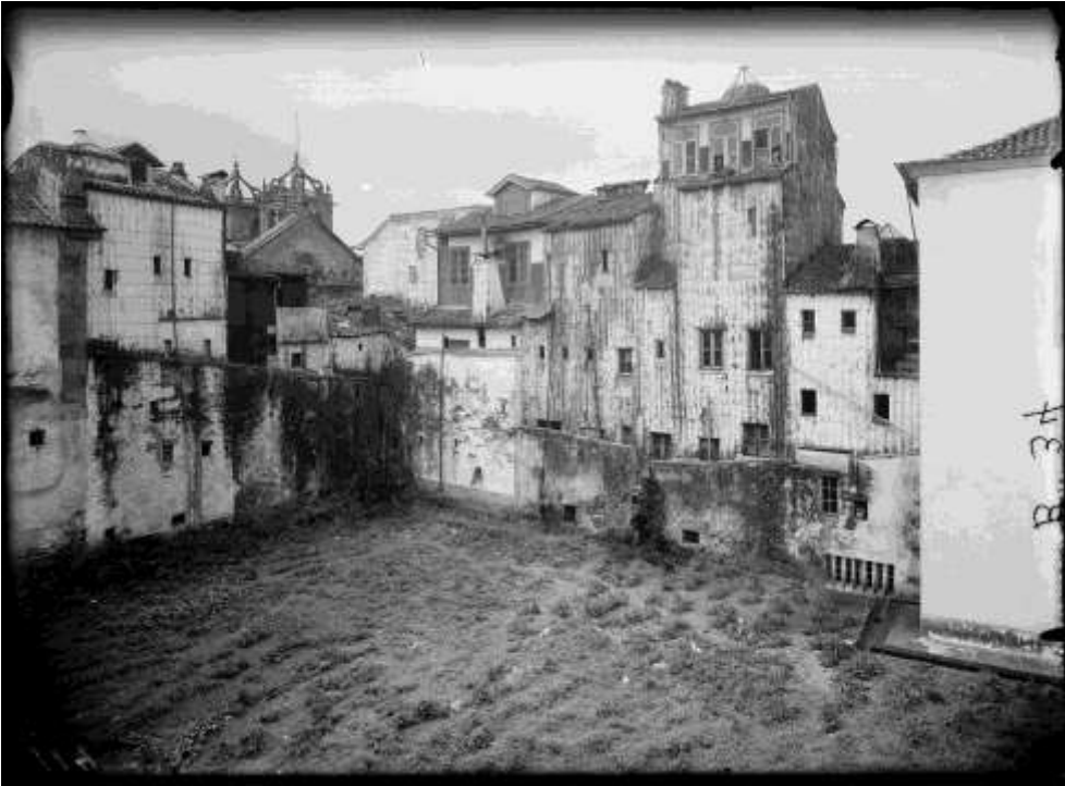
Figura 14 | Fotografia da autoria do estúdio Fotografia Alvão, Lda., do Paço Arquiepiscopal, instalações do arquivo distrital e biblioteca de Braga, Minho [1920-1950]. É possível observar a aplicação da telha cerâmica capa-canal nas fachadas posteriores, empenas, chaminés e coberturas. À semelhança de exemplos registrados na cidade de Guimarães, as telhas cerâmicas apresentam cor branca devido à sua caição. As superfícies visíveis das telhas eram da sua parte côncava e as juntas verticais entre telhas eram preenchidas com argamassa. Atualmente a configuração das fachadas e das coberturas sofreu alterações, bem como os revestimentos em telha cerâmica capa-canal foram substituídos por argamassas. (fonte: CPF. Cota PT-CPF-ALV-001120)
