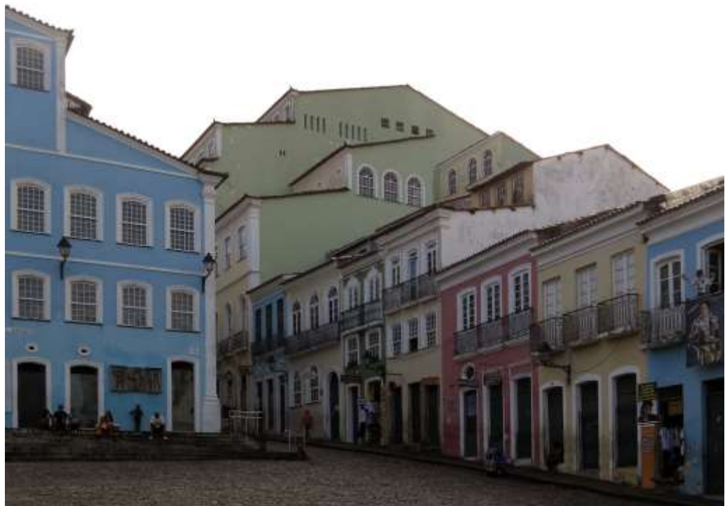
Figura 27 | Vista do Largo do Pelourinho em direção à Rua Alfredo de Brito. Empenas laterais orientadas a nordeste, com coroamento angular e revestidas com argamassa pintadas à cor verde e à cor branco. A morfologia da empena de primeiro plano apresenta um piso suplementar recuado em relação à fachada principal e a empena de segundo plano, onde está instalado o Hotel do Pelourinho, apresenta uma interrupção provocada pela introdução de um pátio no interior do lote. (foto do autor, out./2016)
