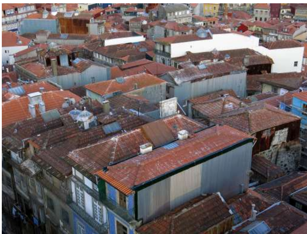
Figura 166 | Vista parcial do conjunto urbano da área da Vitória, no centro histórico do Porto, na qual é possível constatar duas empenas laterais cujo tratamento de superfície se apresenta com revestimento em chapa zincada ondulada branca. De acordo com as cores e texturas dos materiais utilizados na arquitetura corrente do centro histórico, essas empenas laterais manifestam-se com protagonismo na paisagem urbana, devido ao contraste que estabelecem com os demais elementos. Salienta-se a prevalência de empenas com recorte comum e coroamento plano e tratamento das superfícies em chapa zincada ondulada cinzenta (foto do autor, ago./2017).
