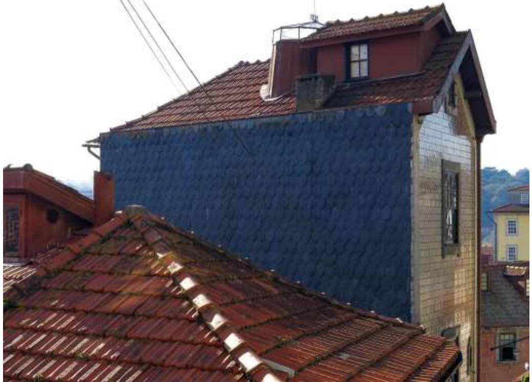
Figura 5 | Edifício nas Escadas do Barredo, Porto. Empena cega revestida com soletos de ardósia. (foto do autor, dez./2016)
