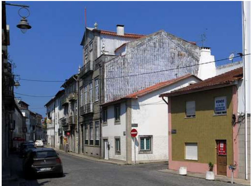
Figura 50 | Vista da Rua Azevedo Coutinho, freguesia de Fão, cidade de Esposende, região do Minho. No enquadramento urbano registrado realça-se a parte da empena que está revestida em telha cerâmica capa-canal, com a parte côncava das telhas orientada para o exterior. Entre os aspectos singulares deste elemento arquitetónico, destaca-se a pintura da telha-cerâmica, já observada em outros exemplares do século XX (ver figura 14), e a aparente transformação morfológica da empena. Acredita-se que a superfície texturizada corresponda a um estado anterior ao atual, já que a superfície da empena que está revestida em telha cerâmica tem um contorno claro e definido, revelando um coroamento angular em oitão. O restante das superfícies lisas da empena sugerem uma intervenção mais recente, possivelmente provocada pelo aumento do pé-direito do piso suplementar e pela introdução de um pátio sobre o alinhamento da rua que se protege atrás da platibanda. (foto realizada pelo autor, ago./2016)
