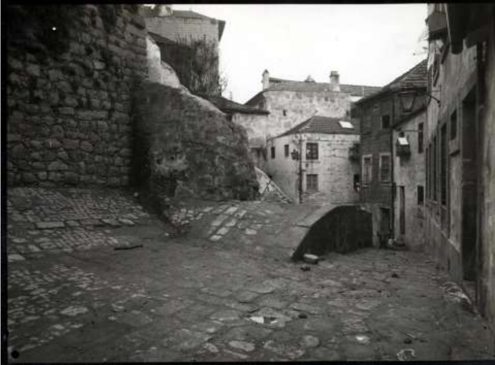
Figura 41 | Fotografias das obras de beneficiação do Barredo. CMP [1968]. (fonte: AHMP. Disponível em: < http://gisaweb.cm-porto.pt/units-of-description/documents/284084/?q=CAIS+DA+RIBEIRA >. Acesso em 2 nov. 2016).
