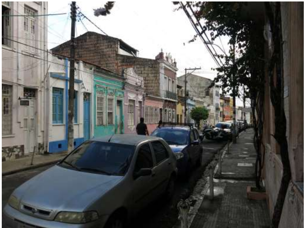
Figura 19 | Fotografia na Rua Direita de Santo Antônio, com uma empena cega revestida em telha cerâmica capa-canal. A superfície visível da telha cerâmica é a parte convexa e as juntas verticais entre telhas são colmatadas com argamassa. Destaca-se a existência de um piso suplementar recuado com introdução de uma inadequada esquadria envidraçada. A configuração triangular da empena é atenuada por essa quebra na vertente orientada para a fachada principal. (foto do autor, out./2016)
