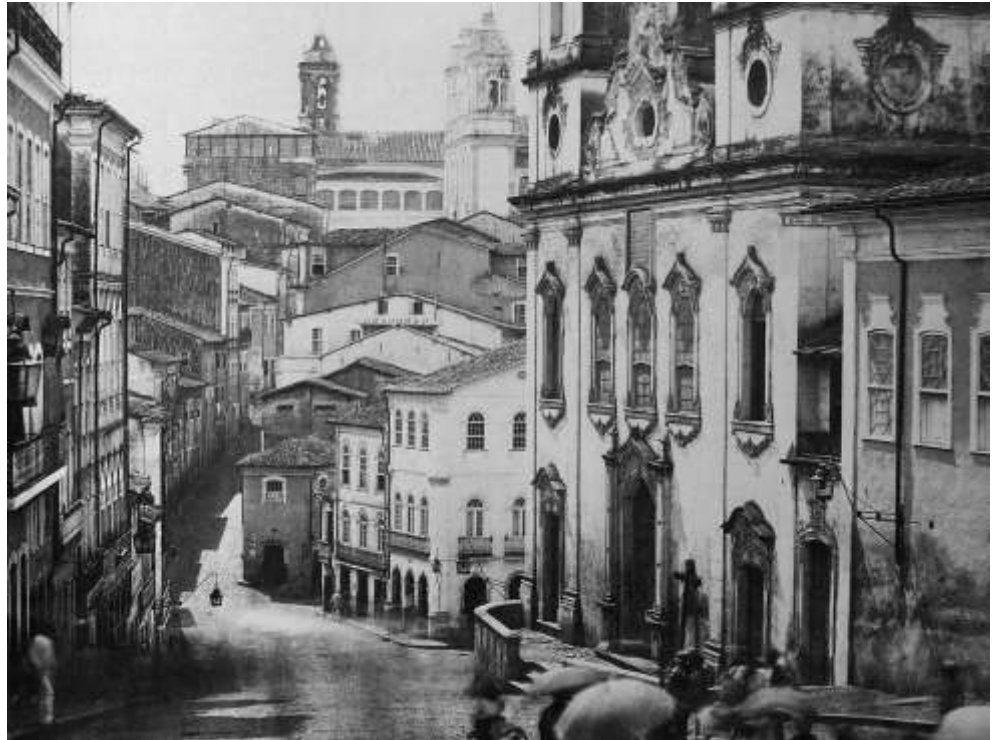
Figura 13 | Fragmento da fotografia de Benjamin Mulock de 1860, com vista da Ladeira do Carmo e do Convento a partir do Largo do Pelourinho. É possível observar a acentuada visibilidade das empenas da Ladeira do Carmo. Salienta-se a existência de duas empenas laterais revestidas em telha cerâmica capa-canal, orientadas a sul (lado esquerdo da imagem). Essas empenas laterais pertenciam aos sobrados com os números 16 e 20 da Ladeira do Carmo. (fonte: FERREZ, 1988, p.50 e 51).
