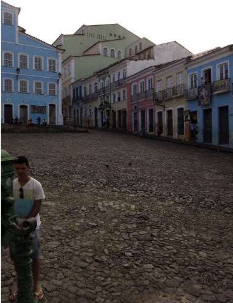
Figura 173 | Vista a partir do Largo do Pelourinho das empenas laterais do sobrado onde está instalado o Hotel do Pelourinho. De acordo com a declividade do terreno e a falta de constância dos gabaritos dos sobrados, as empenas revestidas em argamassa pintada à cor verde adquirem uma visibilidade e protagonismo acentuados. (foto do autor, out./2016)
