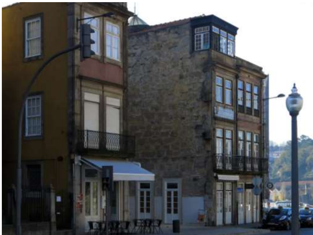
Figura 159 | Vista de edifício na Rua do Infante D. Henrique (antiga Rua Nova), junto à Igreja de São Nicolau, na cota baixa da cidade do Porto. Em primeiro plano é visível uma empena consolidada com tratamento de superfície lisa revestida em argamassa e pintada à cor amarelo e vazada. Em segundo plano é visível uma empena semi-fragilizada devido à falta de consolidação do seu tratamento de superfície, devido ao descolamento parcial das argamassas de revestimento. É de destacar a presença de um balcão encerrado no último pavimento, bem como um conjunto de pedras de espera no cunhal. (foto do autor, dez./2016)
