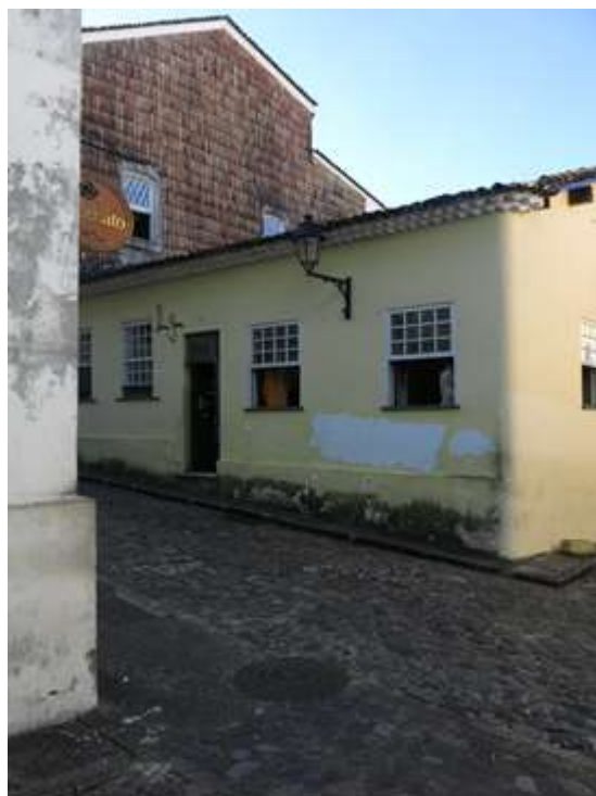
Figura 65 | Estação C do cruzamento entre a Rua Gregório de Matos (antiga Rua Maciel de Baixo) e a Rua Francisco Muniz Barreto (antiga Rua das Laranjeiras). (foto do autor, abr./2017)
