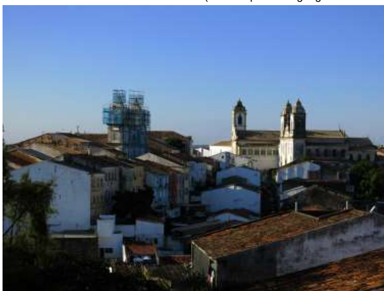
Figura 88 | Vista do casario da Rua do Passo e da Ladeira do Carmo, com o enquadramento da Igreja do Santíssimo Sacramento do Passo e Igreja e Convento do Carmo, registrada a partir do edifício do Hotel do Pelourinho. Considera-se pertinente salientar que as empenas da Ladeira do Carmo adquirem mais visibilidade que as da Rua do Passo, em função da topografia do terreno. (foto do autor, mai./2017)
