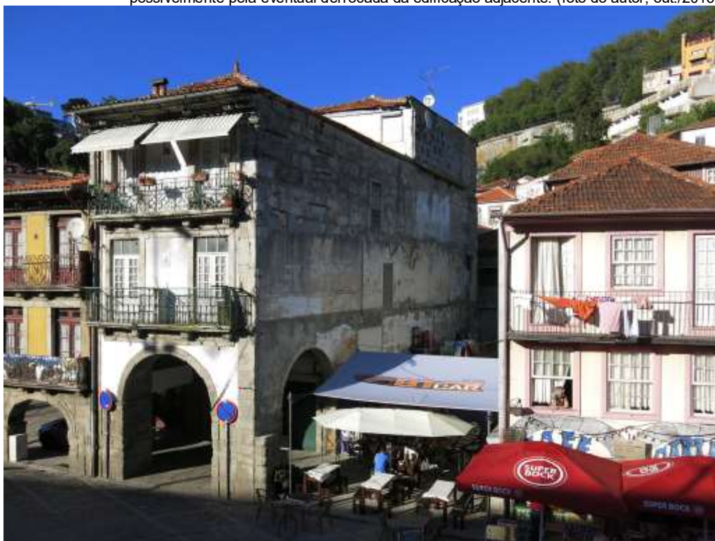
Figura 165 | Vista parcial do conjunto urbano na Rua de Miragaia, na freguesia de Miragaia, à cota baixa do Porto, na qual é possível constatar uma empena lateral cujo tratamento de superfície se manifesta sem revestimento, possivelmente pela eventual derrocada do edifício vizinho. (foto do autor, dez./2016)
