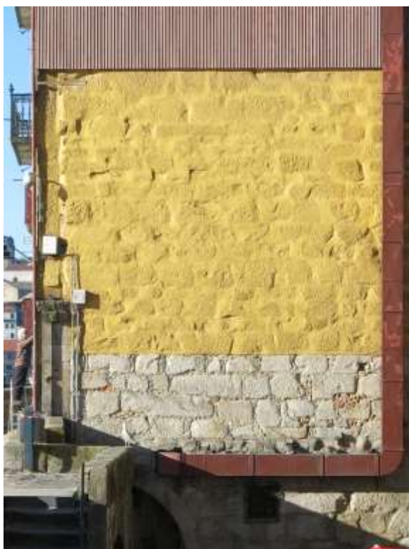
Figura 177 | Vista da empena lateral da Rua de Cimo do Muro. De acordo com o critério de tratamento de superfície, nesse momento tratar-se-ia de uma empena texturizada e vazada. (foto do autor, dez./2016)
