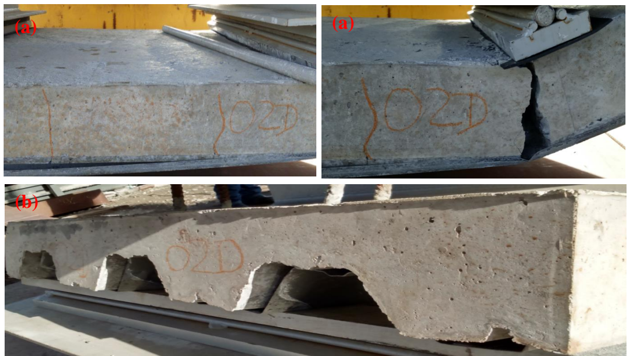
Figura 79: Fissuras (a) e deslizamento relativo(b) após ruptura da amostra RM75-02D.
