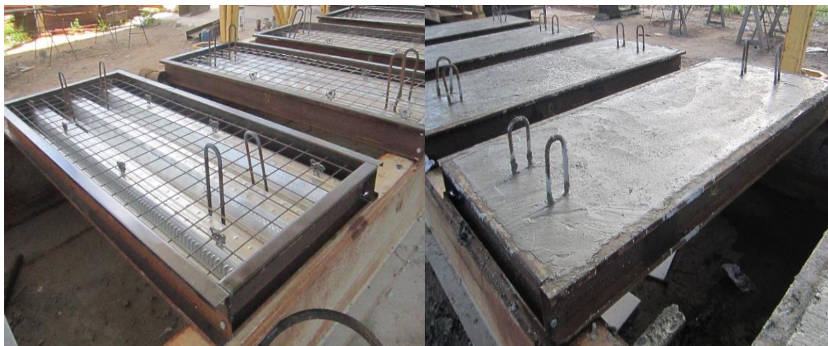
Figura 45: Fôrma utilizada para concretagem dos modelos normativos
