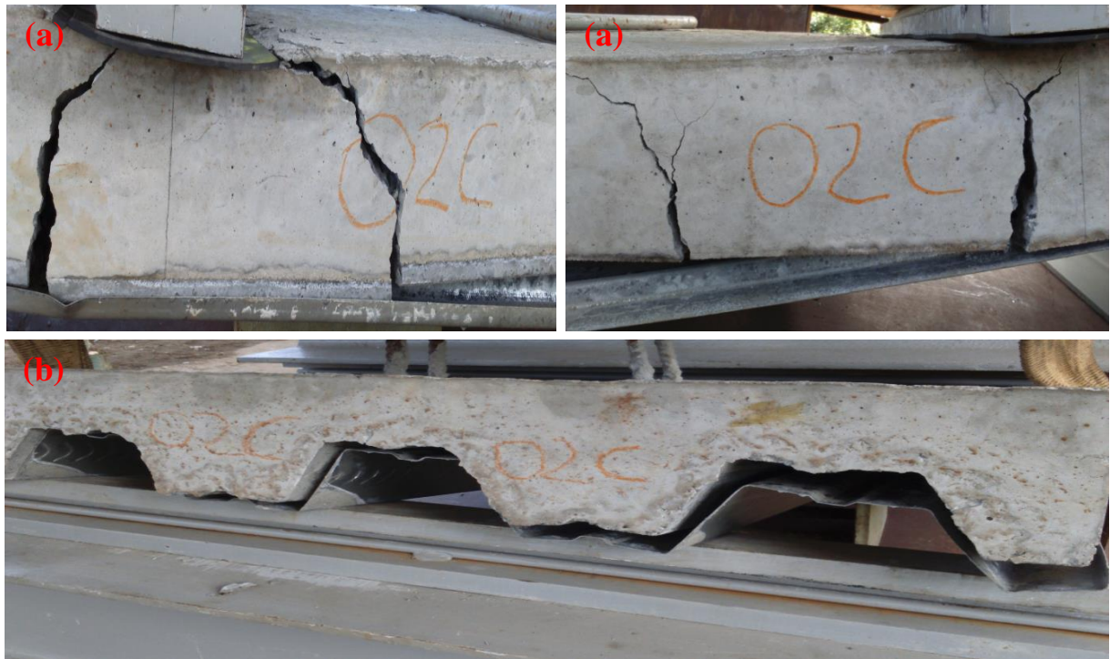
Figura 78: Fissuras (a) e deslizamento relativo (b) após ruptura da amostra RM75-02C.
