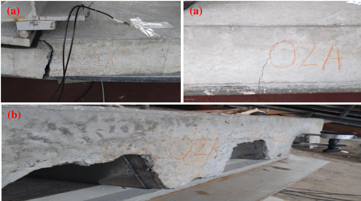
Figura 76: Fissuras (a) e deslizamento relativo (b) após ruptura da amostra RM75-02A.
