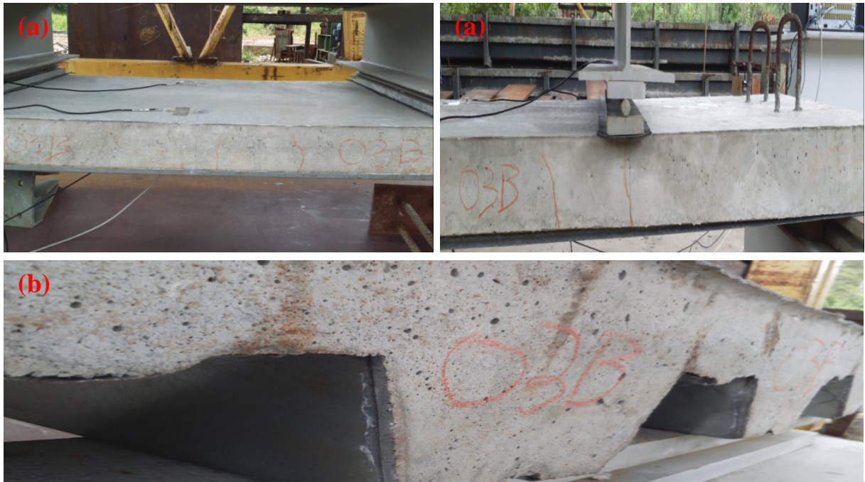
Figura 87: Fissuras (a) e deslizamento relativo (b) após ruptura da amostra RM75-03 B.
