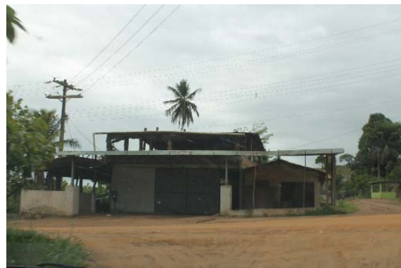
8b – Comunidade de Engenheiro Pontes
