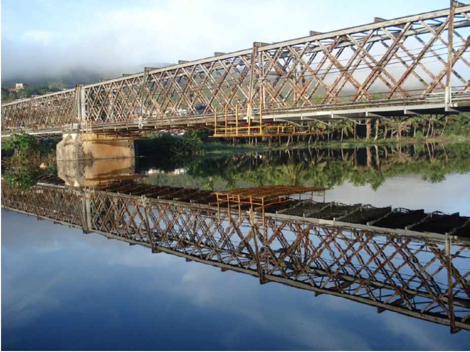
Figura 4 - Ponte D. Pedro II sobre o Rio Paraguaçu
