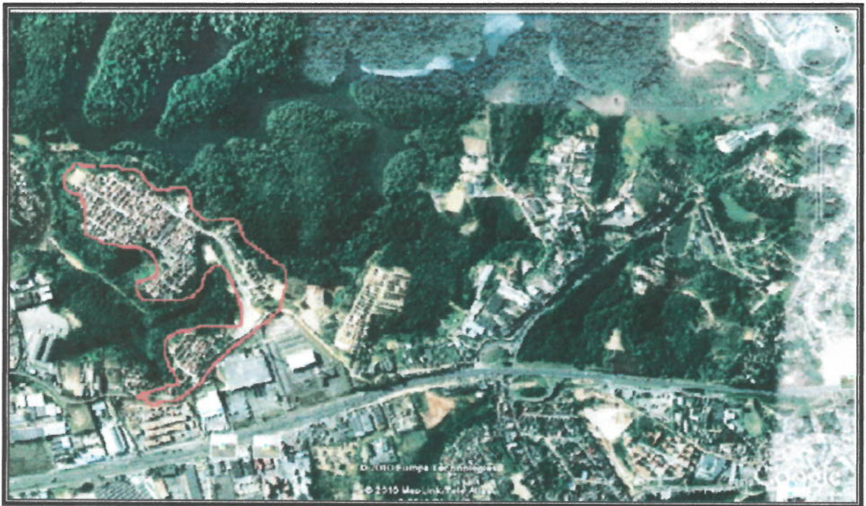
Figura 4: Vista aérea do Rio do Cobre e de parte da BR-324
