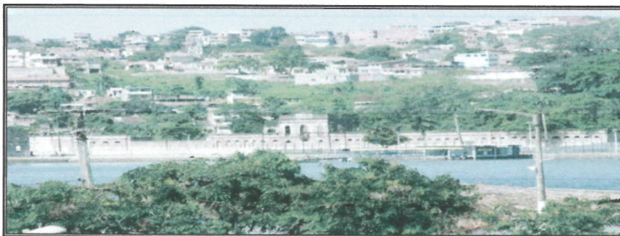
Figura 6: Fábrica São Braz no bairro do São João do Cabrito e ao fundo o bairro de Plataforma, 2012
