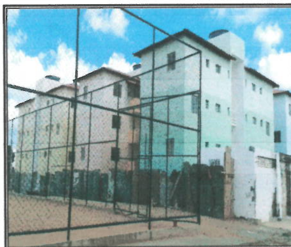
Foto 12: Unidades habit. em construção
