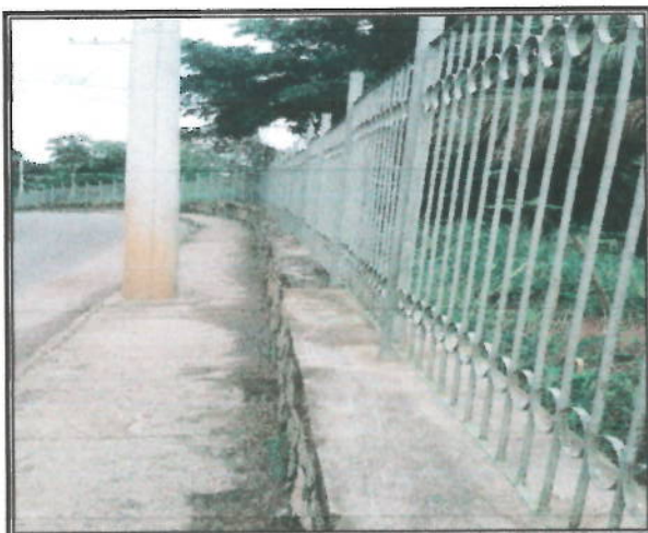
Foto 9: Via de Contorno/Sistema de Proteção
