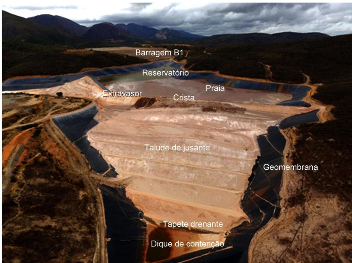
Figura 4.3. Principais estruturas da barragem B2 (JMC, 2016 (modificado)).
