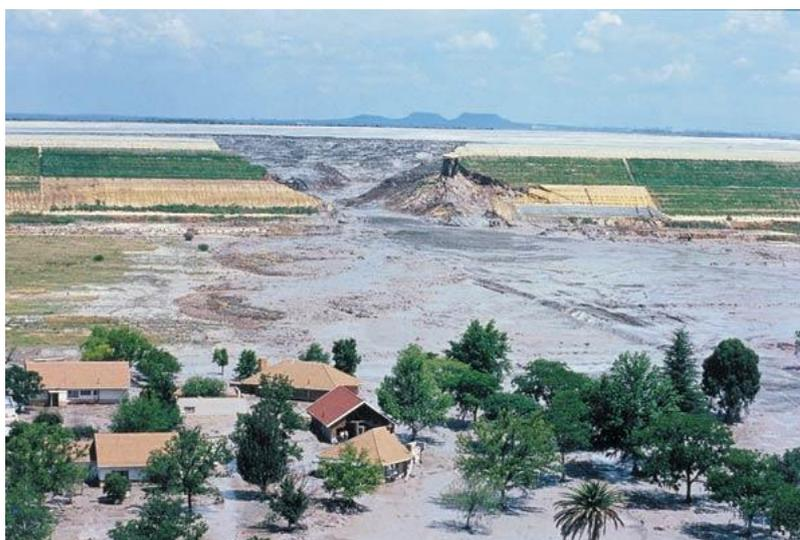
Figura 2.13. Ruptura ocorrida na barragem de Merriespruit na África do Sul em 1994. (<http://www.tailings.info/assets/images/accidents/merriespruit.jpg>. Acesso em: 14/09/2016).
