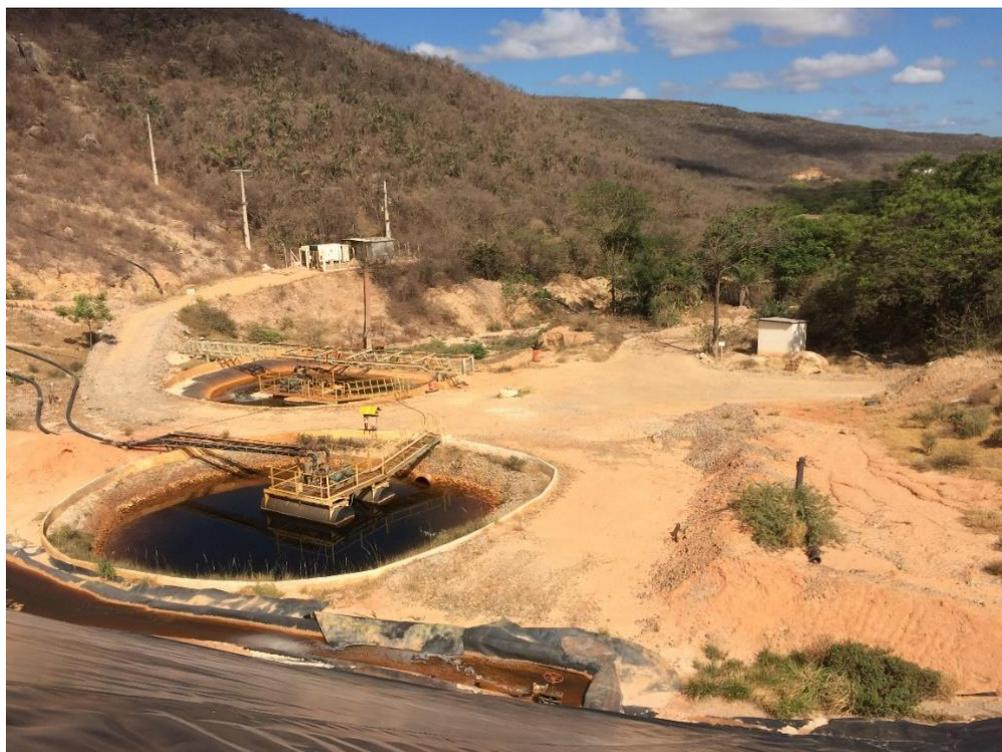
Figura 4.5. Poço de percolados a jusante da barragem. Fonte: O autor.
