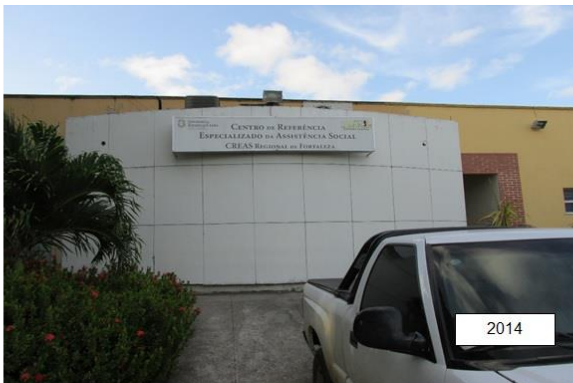
Figura 15 - Fachada do CREAS-RF.
