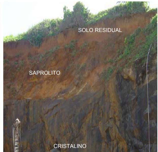
**Foto 3.2B** Perfil mostrando de cima para baixo o solo residual, o saprolito e a rocha não alterada - Pedreira do Quartel de Amaralina
