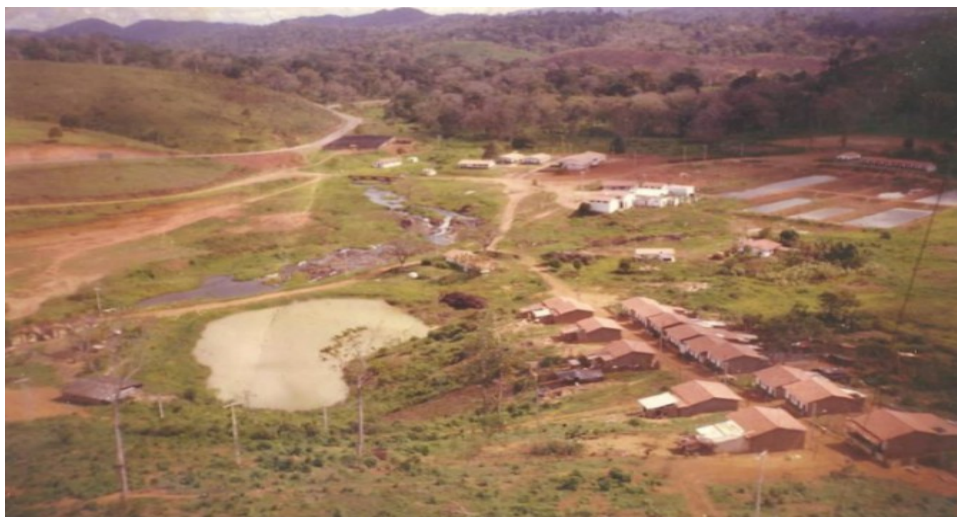
Figura 01: Início da estruturação no assentamento Terra Vista, em 1998.
