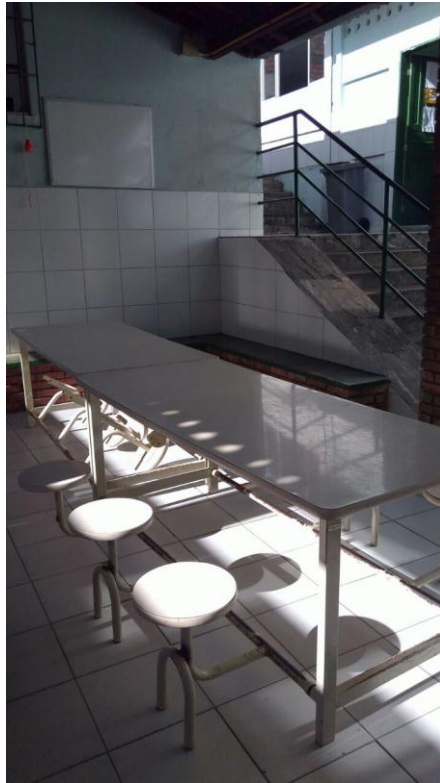
FIGURA 14 – Refeitório na Escola Municipal em Salvador. Fotos fornecidas pela gestora da escola.
