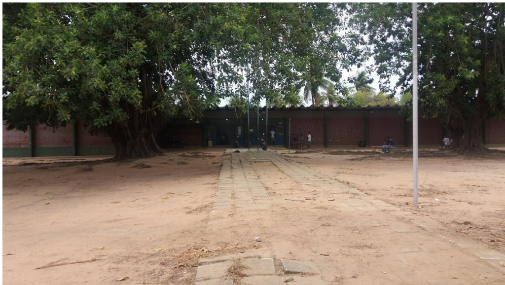
FIGURA 5 – Fachada da Escola Estadual em Feira de Santana
