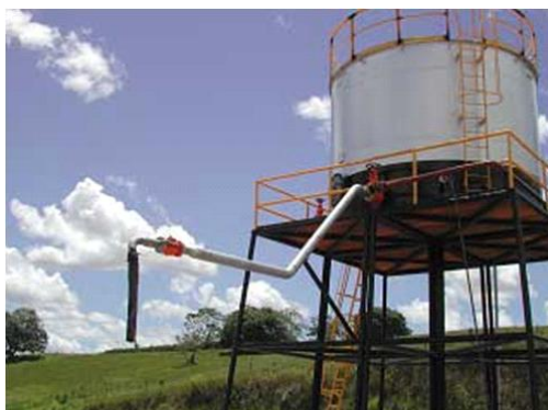
Figura 7 –Poço Quiambina 4-A revitalizado
