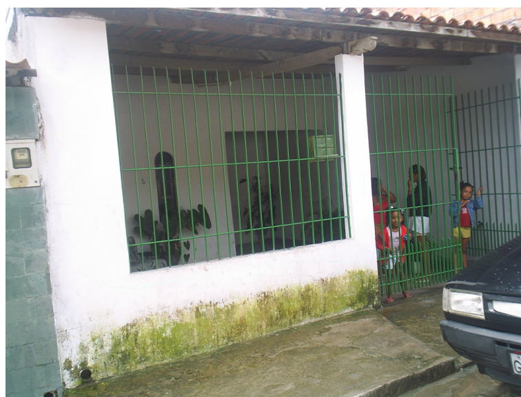
Foto 6: Residência 4, localizada na Rua Araguari, Eucalipto.
