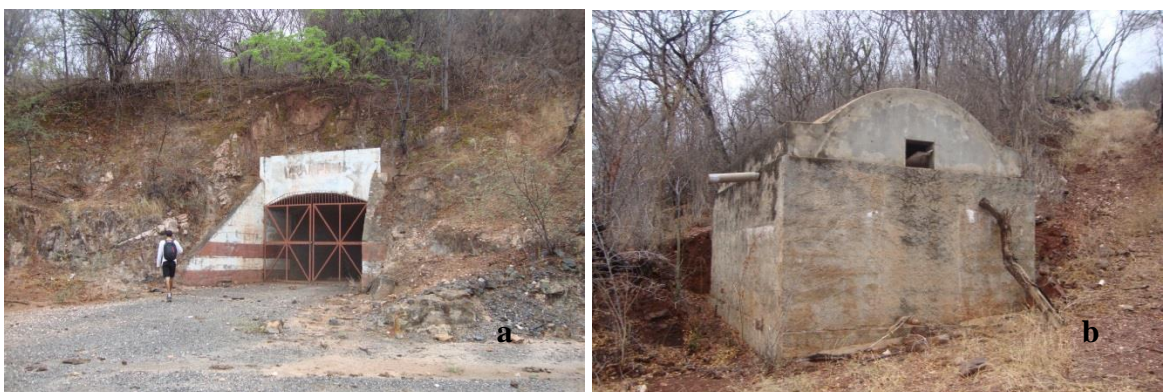
FIGURA 3.4: FOTOS DAS ESTRUTURAS DE APOIO DA MINERAÇÃO DE CHUMBO ABANDONADA
