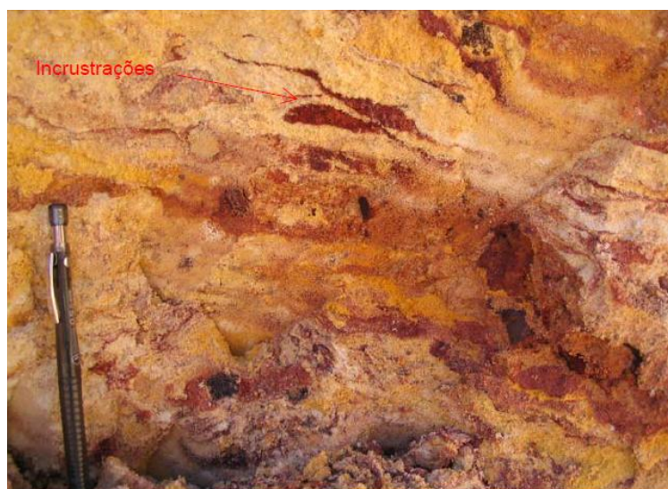
Fotografia 2.1: Incrustações ferruginosas na forma de manchas irregulares da Formação Barreiras localizadas ao sul da Cetrel.
