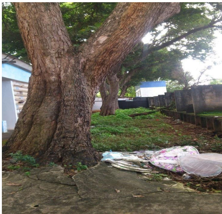
Figura 78. Corredor de arvores de raiz radicular, deteriorando o piso e arruamento do cemitério Quinta dos Lázarus. Logo no seu entorno restos de exumação.
