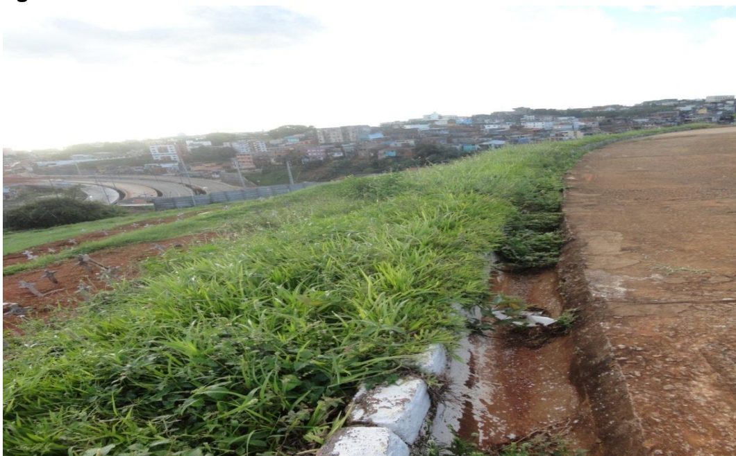
Figura 80. Calhas obstruídas.
