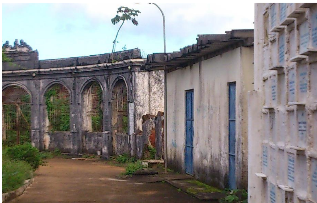
Figura 87. Forno de incineração (em desuso).
