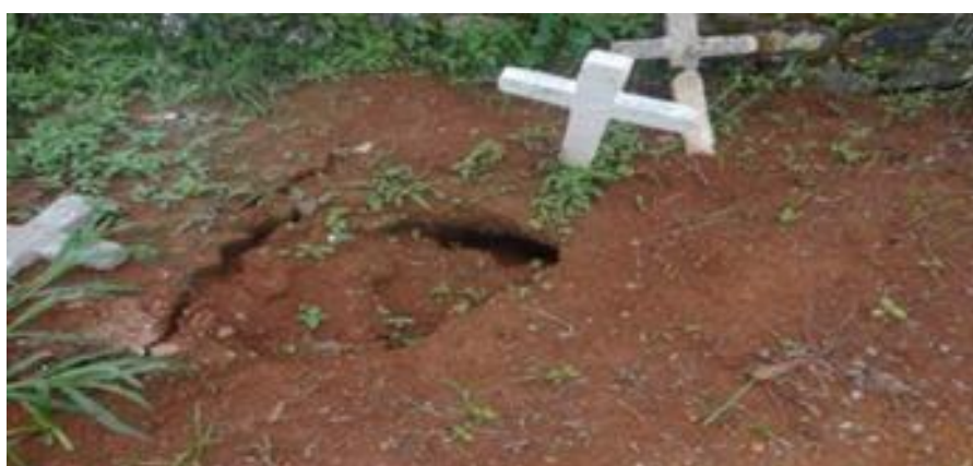
Figura 60. Cova em processo de erosão
