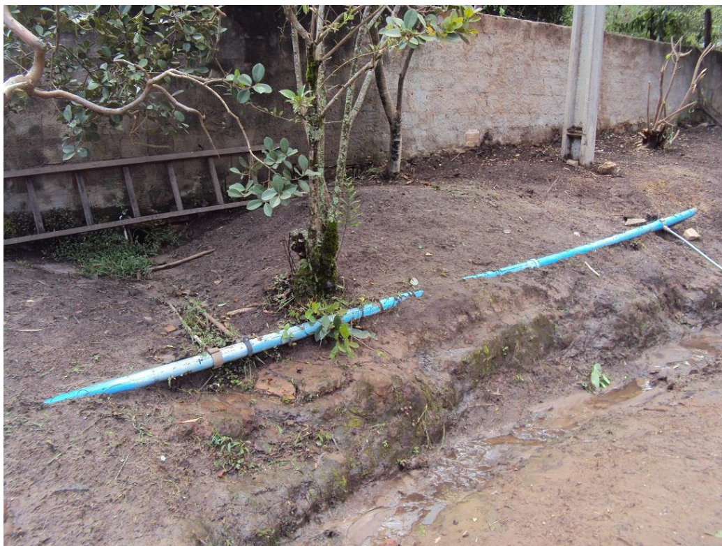
Figura 19: Detalhe de 3 ramais sobre a rede central do Bomba, na região do “seu João”
