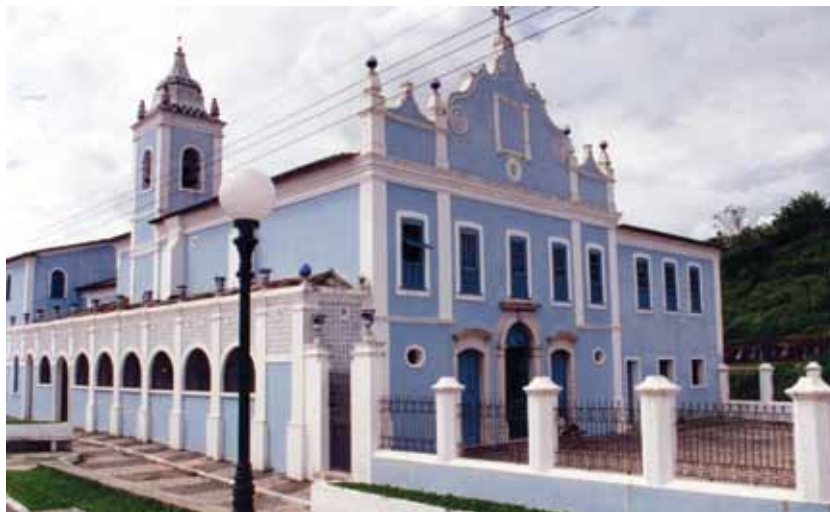
Figura 1 - Igreja e Convento do Recolhimento de Nossa Senhora dos Humildes, Santo Amaro da Purificação, Bahia.
