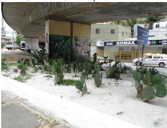
FIGURA 44 – VIADUTO LIGAÇÃO CANELA/CAMPO GRANDE, SALVADOR-BA, 2014
