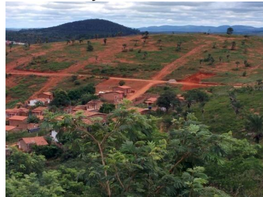
Foto 09 Ruas sem calçamento
