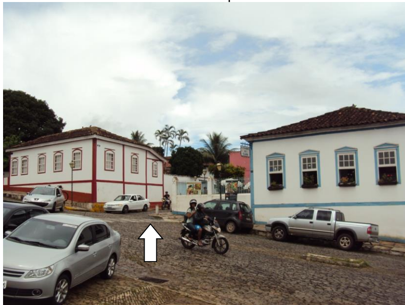
Figura 9: Travessia em pedra (passarela de pedestres) e calçada rebaixada. Centro Histórico de Pirenópolis – Goiás.
