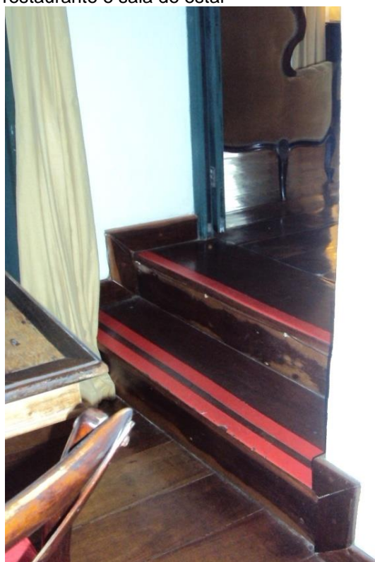
Figura 71: Praça Anchieta, nº 16/18 Hotel Villa Bahia – degraus entre restaurante e sala de estar
