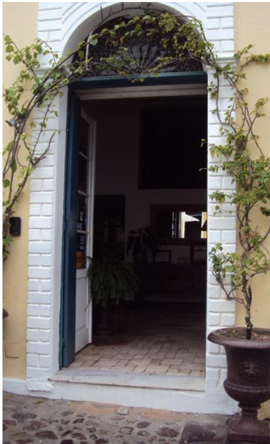
Figura 65: Praça Anchieta, nº 16/18 Porta de acesso ao hotel
