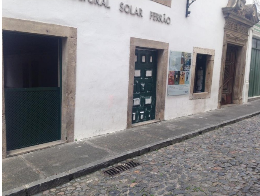
Figura 29: Passeio da Rota Acessível do CHS – trecho em frente ao Solar Ferrão (entrada para visitantes à direita na fotografia)
