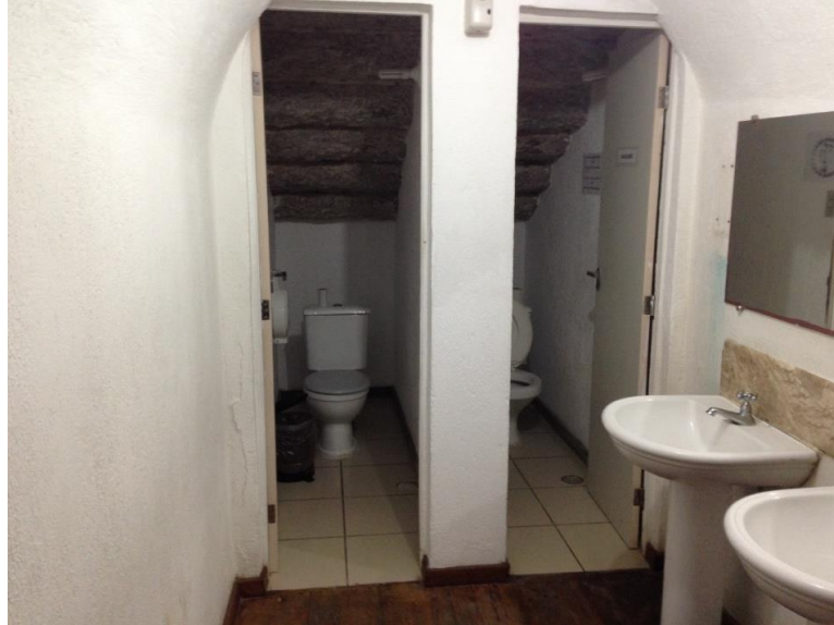
Figura 33: Galeria Solar Ferrão – sanitários feminino e masculino
