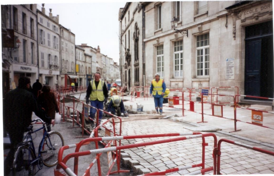
Figura 5: Obras de pavimentação urbana. La Rochelle – França
