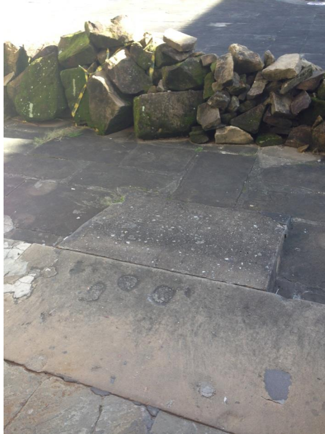
Figura 98: Igreja de São Francisco – Rampa de acesso à área central do Claustro
