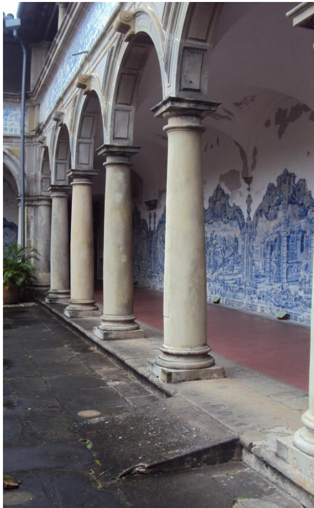
Figura 96: Igreja de São Francisco – Rampa de acesso à área central do Claustro
