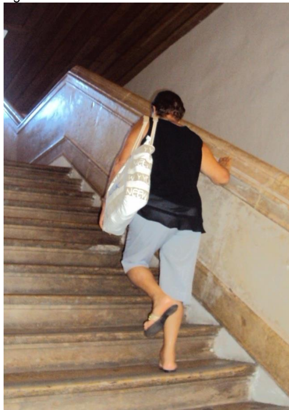
Figura 50: Solar Ferrão – escadaria – visita 01
