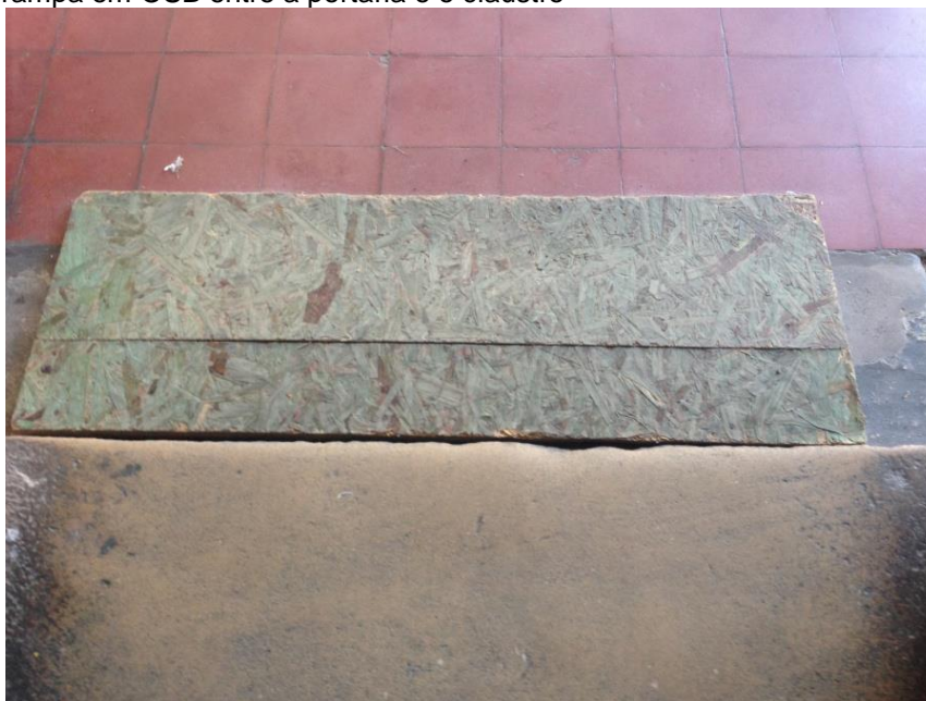
Figura 95: Igreja de São Francisco – Soleira (parte inferior da imagem) e rampa em OSB entre a portaria e o claustro
