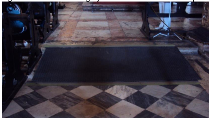
Figura 102: Interior da Igreja de São Francisco – rampa
