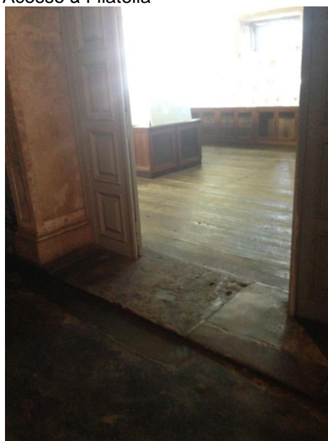
Figura 104: Igreja de São Francisco. Acesso à Filatelia
