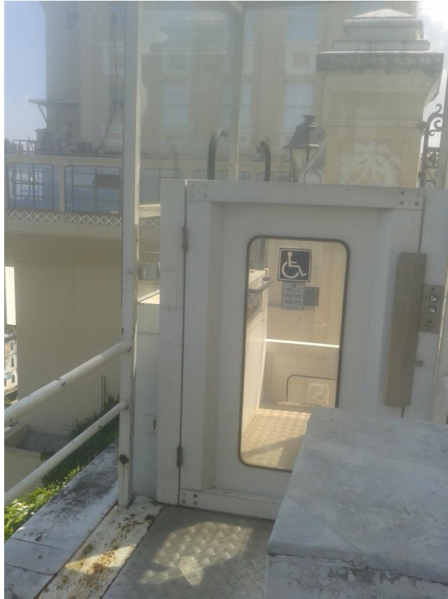
Figura 24: elevador (desativado) para acesso de deficientes físicos, instalado no Palácio Rio Branco – CHS. Ao fundo, o Elevador Lacerda.
