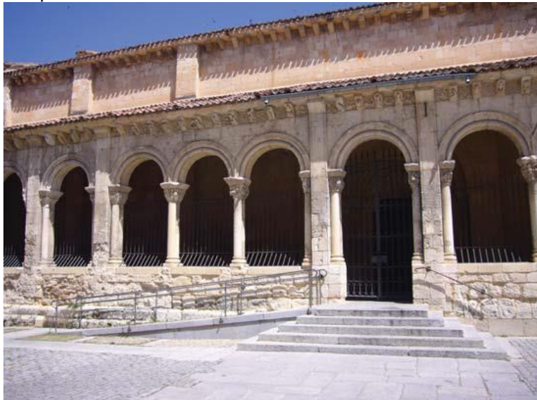
Figura 3: Igreja de San Millán – Segovia – Espanha. Rampa e escadas de acesso.
