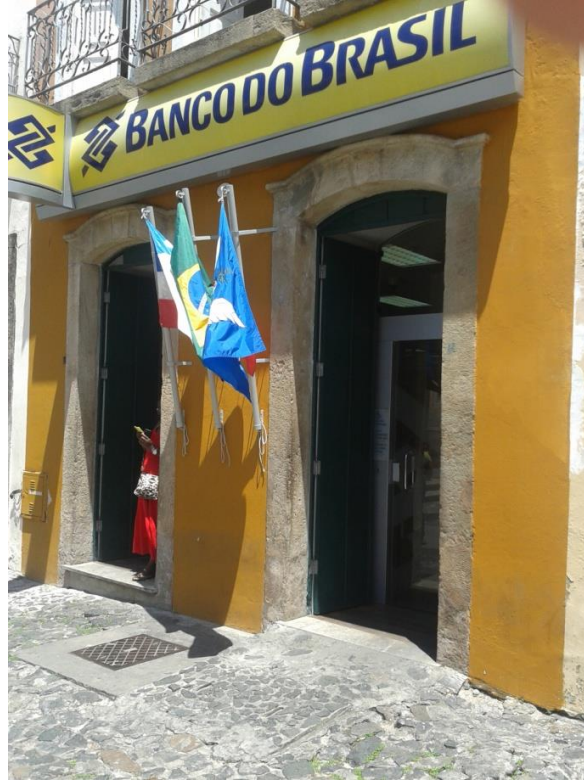
Figura 22: rampa de acesso ao imóvel sito à Praça Anchieta, 13 – agência do Banco do Brasil – Salvador – BA
