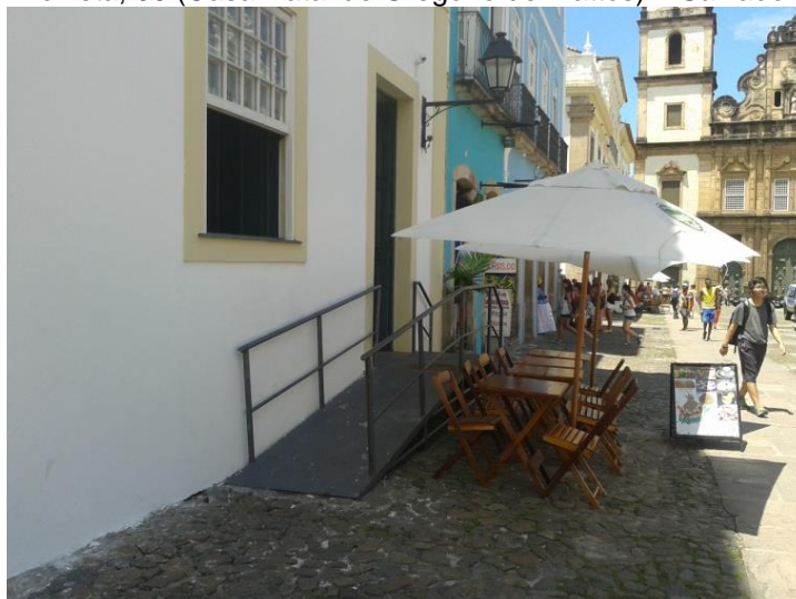
Figura 21: Rampa removível de acesso ao imóvel sito à Praça Anchieta, 08 (Casa Natal de Gregório de Mattos) – Salvador – BA.
