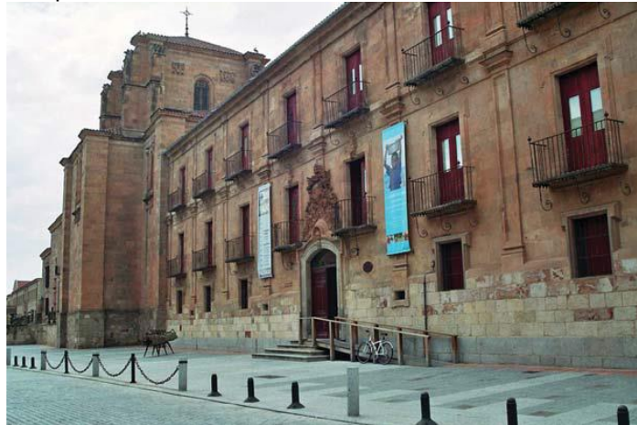
Figura 4: Edifício histórico em Salamanca – Espanha. Rampa de acesso em madeira.
