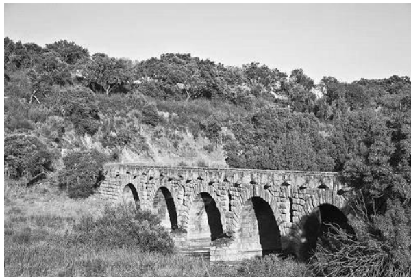
(a) Ponte Romana de Vila Formosa, Pt. Fonte: Disponível em: < http://www.origens.pt/explorar/doc >.
