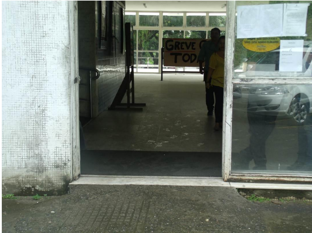
FIGURA 9 – Acesso aos elevadores
