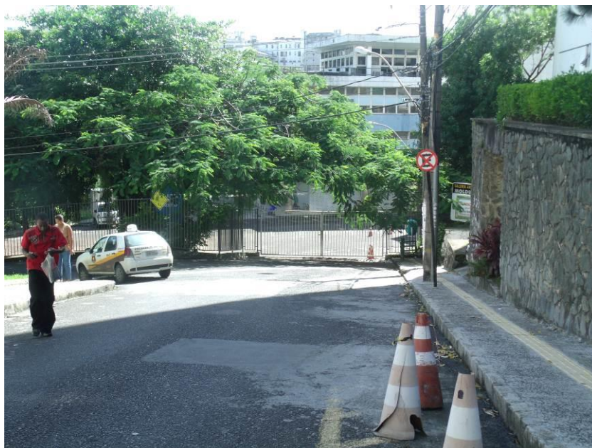
FIGURA 8 – Acesso pela rua da Graça
