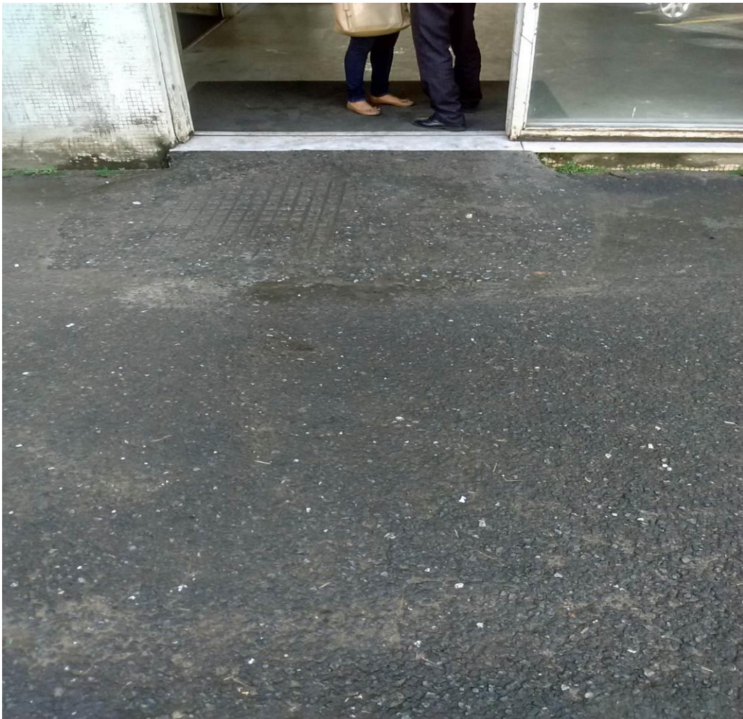
FIGURA 14 – Improvise de rampa para acesso ao elevador
