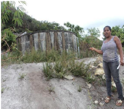
Figura 12 Sistema para abastecimento de água no Povoado de Bananeiras
