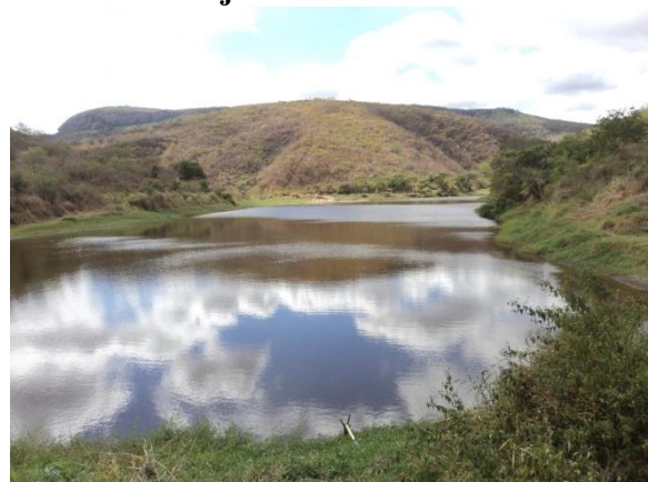
Figura 9 Barragem para abastecimento de água do Povoado de Brejo Grande
