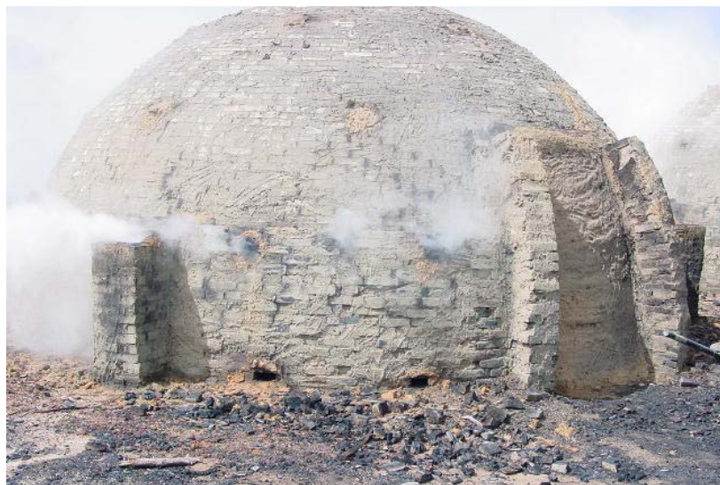
Figura 3. Forno de alvenaria, semi-circular, sem chaminé, apresentando os orifícios por onde sai a fumaça.
