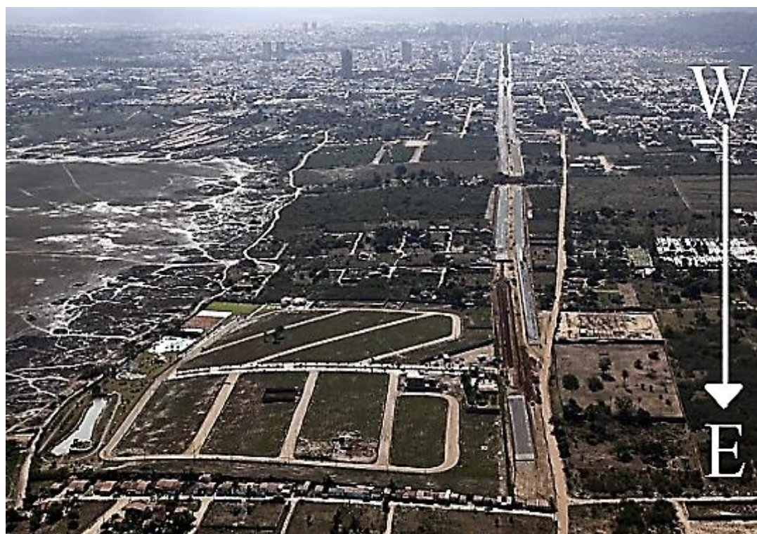
Figura 54. Prolongamento e asfaltamento da Av. Noide Cerqueira na zona leste de Feira de Santana 2013
