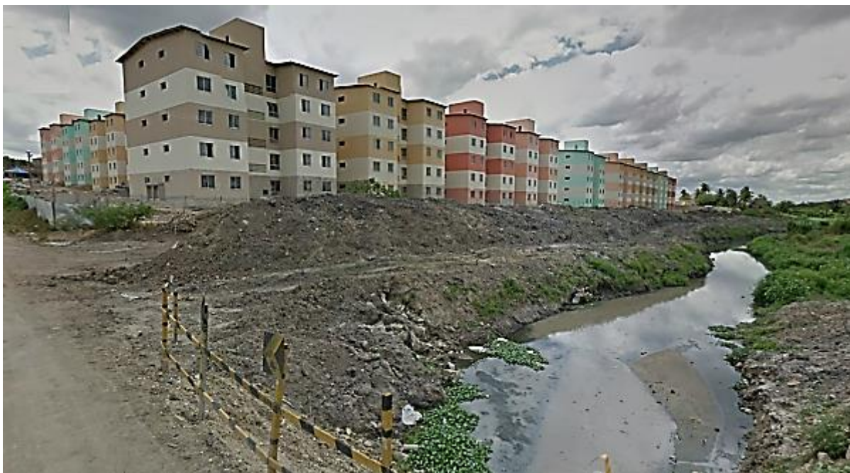
Figura 82. Empreendimento do MCMV no bairro Mangabeira em Feira de Santana, destaque para a falta de infraestrutura do local, 2012
