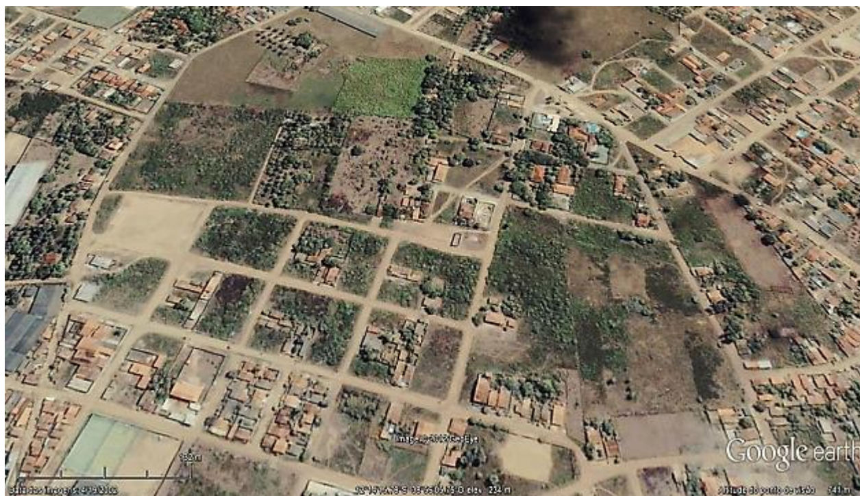
Figura 83. Visão parcial do bairro Conceição com destaque para a construção dos empreendimentos (da esquerda para a direita) Golden Ville, Parque das Hortências e Vivendas Rio D'ouro, 2002-2008
